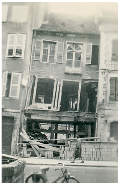
Etat de la façade du n°9 rue de la Liberté en 1958.
