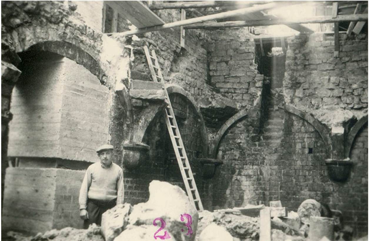
Vue de la cave pendant les travaux de démolition, s.d. [1958].
