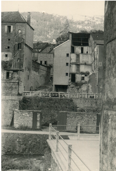
Vue depuis l'ouest après démolition, s.d. [vers 1959].
