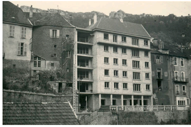
Immeuble en voie d'achèvement, s.d. [vers 1961].
