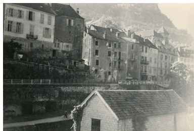
Vue d'ensemble depuis le nord-ouest, avant démolition, s.d. [vers 1957].
