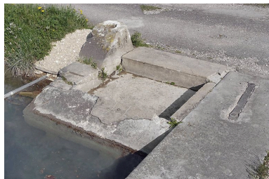
Lavoir maçonné à l'usage des éclusiers, placé avant la tête amont de l'écluse.
