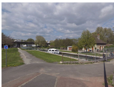
Vue d'ensemble, d'aval.
