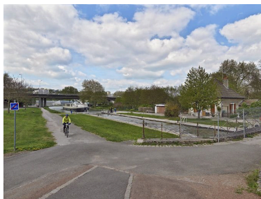
Vue d'ensemble : le site d'écluse, le pont ancien sur écluse peu visible car dissimulé par le nouveau pont avec des garde-corps bleus.
