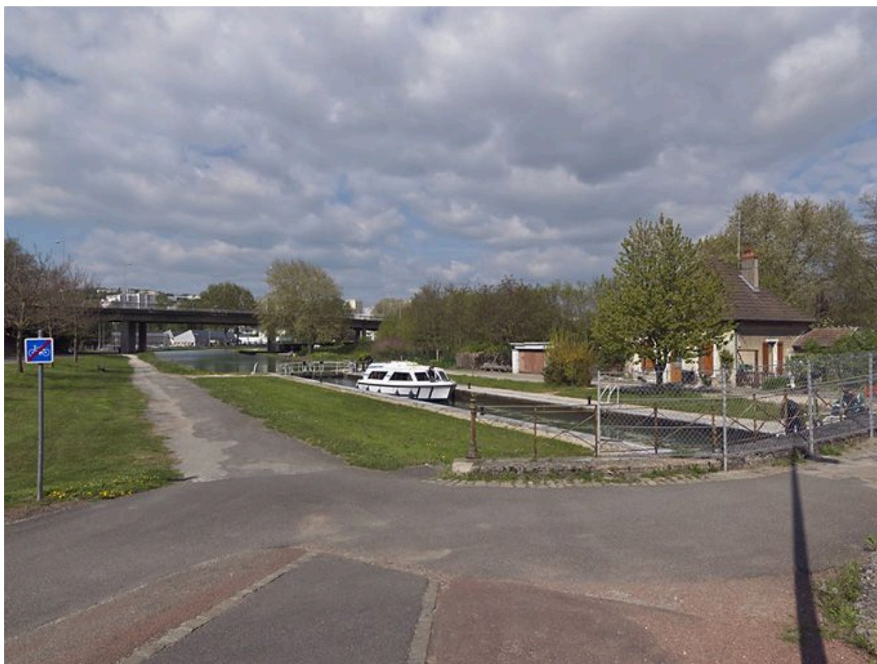
Vue d'ensemble, d'aval.
