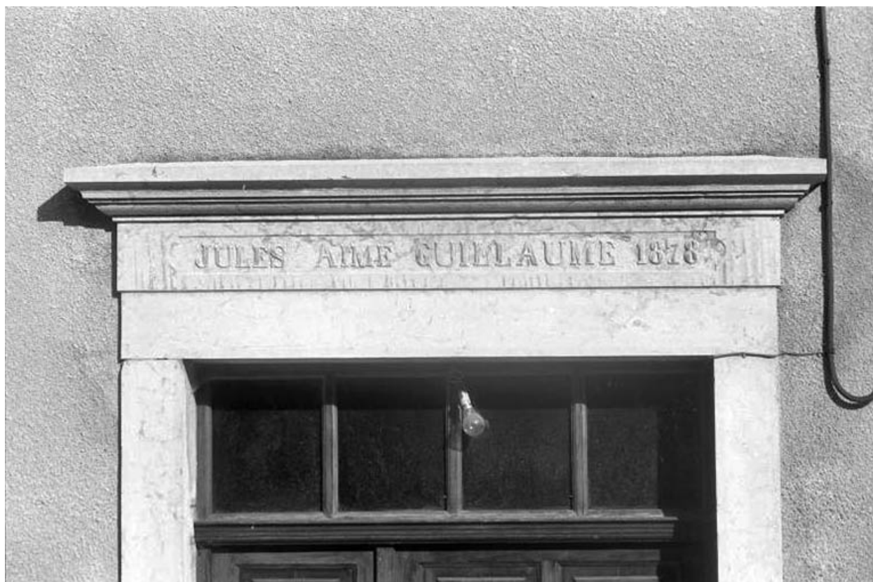
Linteau de la porte d'entrée.
