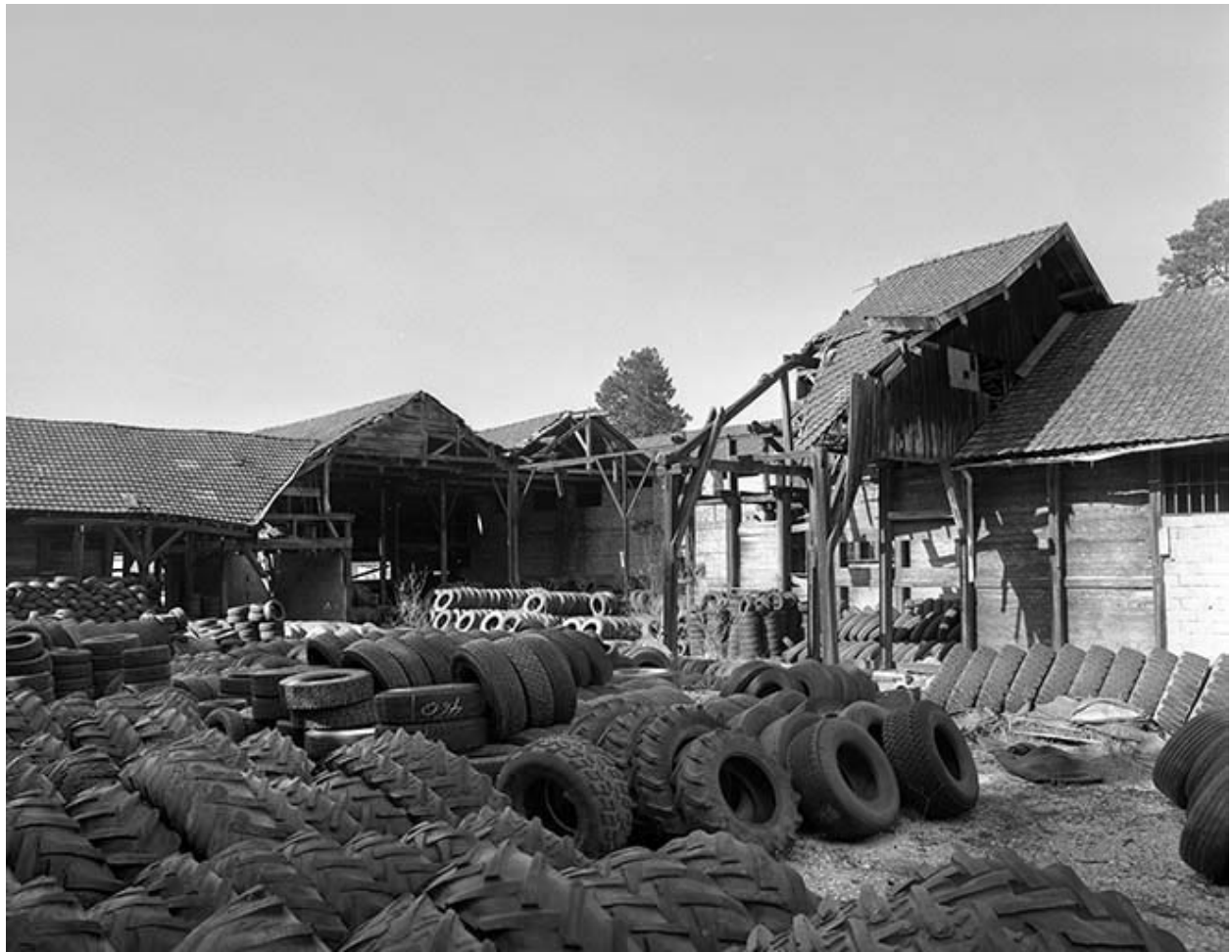
Magasins industriels depuis le nord.
