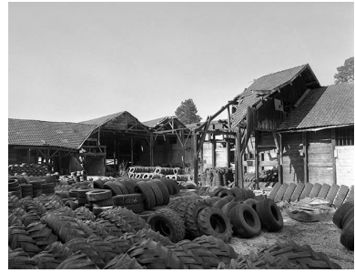
Magasins industriels depuis le nord. Phot. Yves Sancey IVR43_19992500024X
