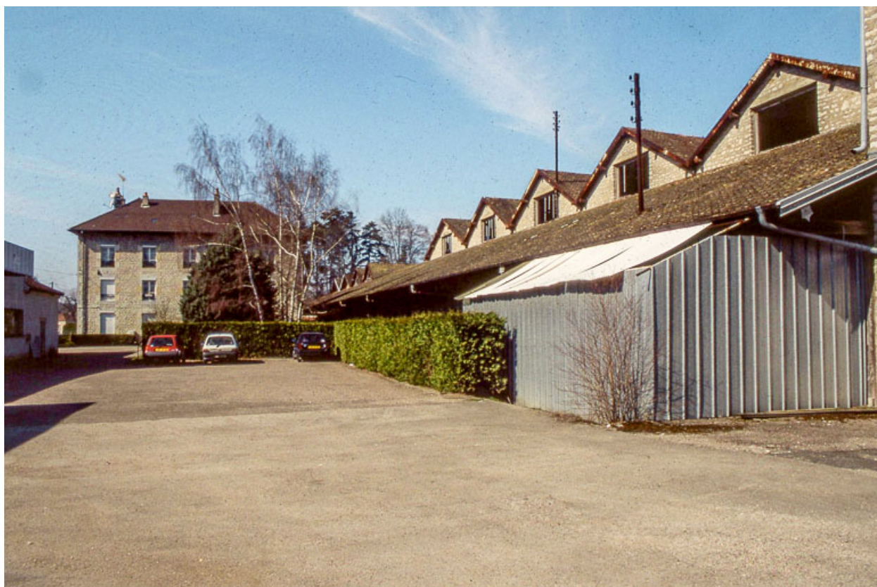
Vue d'ensemble depuis le sud.
