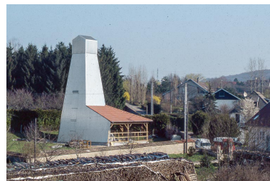
Puits de sondage sud (en service) depuis l'entrée.
