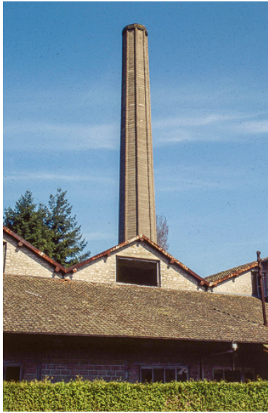
Quai couvert, magasins industriels et cheminée. Phot. Yves Sancey IVR43_19992500010ZA
