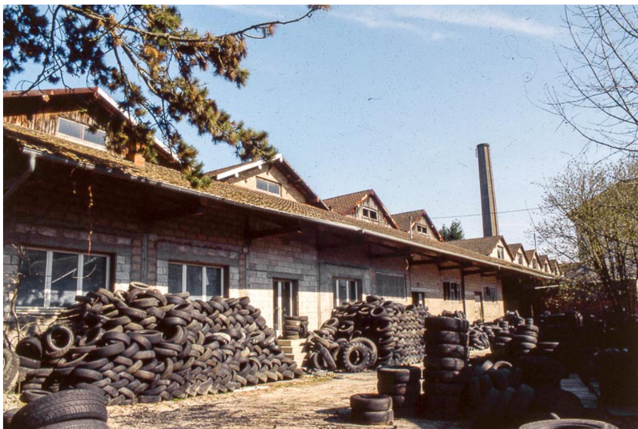
Quai couvert et magasins industriels depuis l'ouest.
