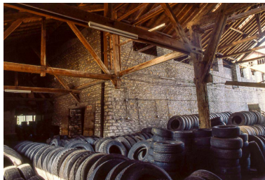
Charpente du quai et magasin industriel. Phot. Yves Sancey IVR43_19992500028ZA
