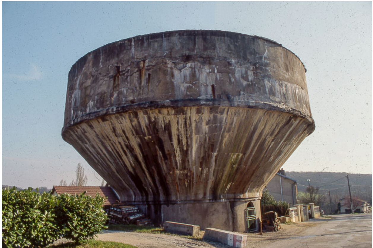
Réservoir industriel (depuis le nord).
