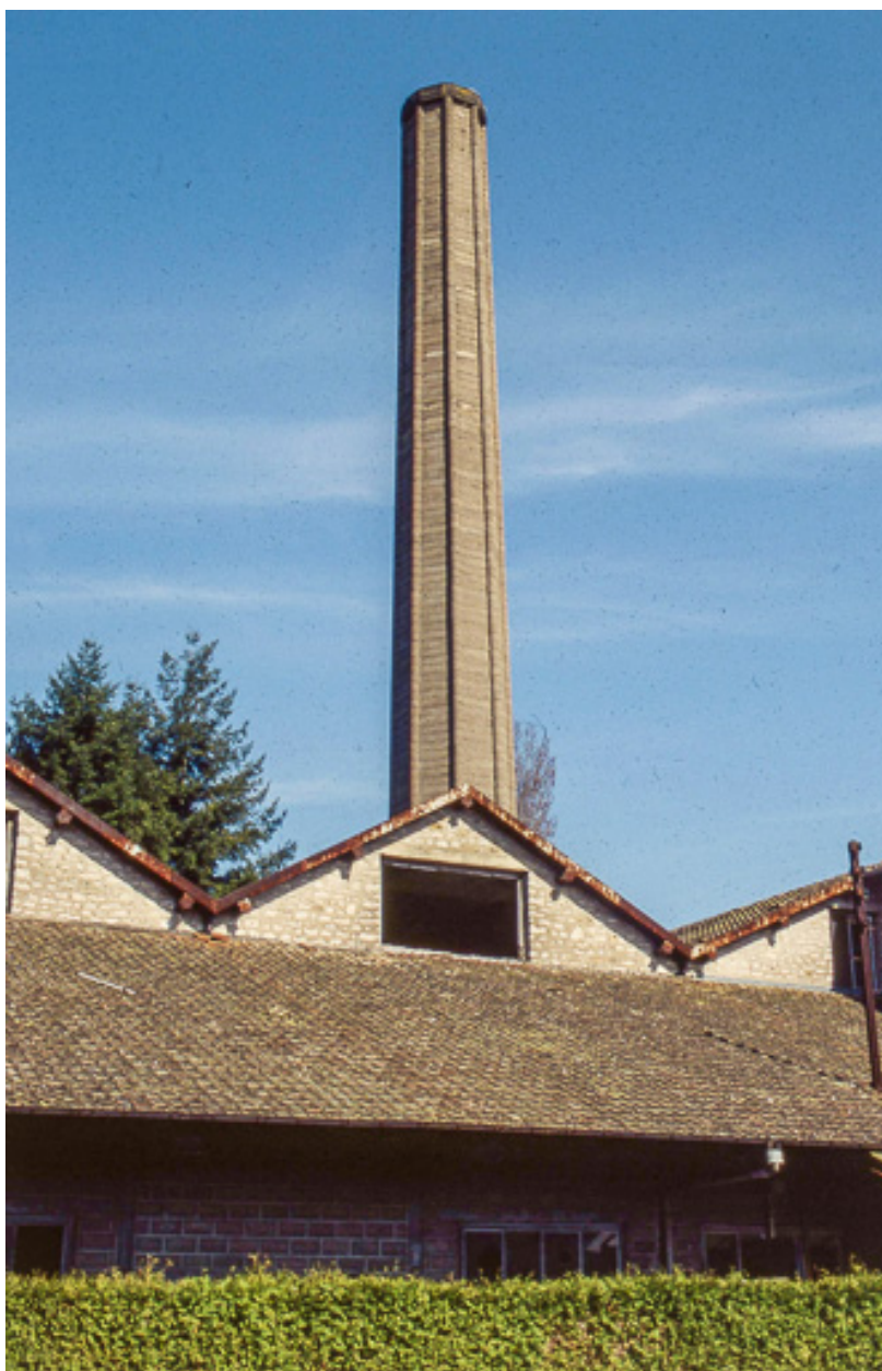
Quai couvert, magasins industriels et cheminée.
