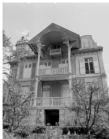
Façade postérieure, partie centrale. Phot. Yves Sancey IVR43_19833900162X
