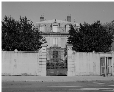
Portail d'accès à l'édifice. Phot. Yves Sancey IVR43_19833900159X
