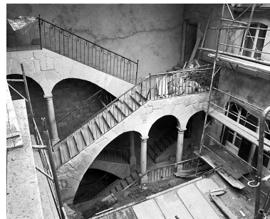
Escalier sur cour intérieure. Phot. Yves Sancey IVR43_19812500132X
