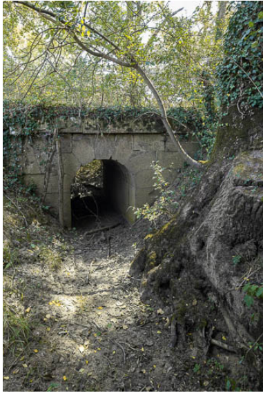
Vue du ponceau.
