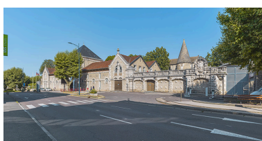
Les anciens établissements Calvet et la tour des Poudres. Phot. Thierry Kuntz IVR26_20232100495NUC4A
