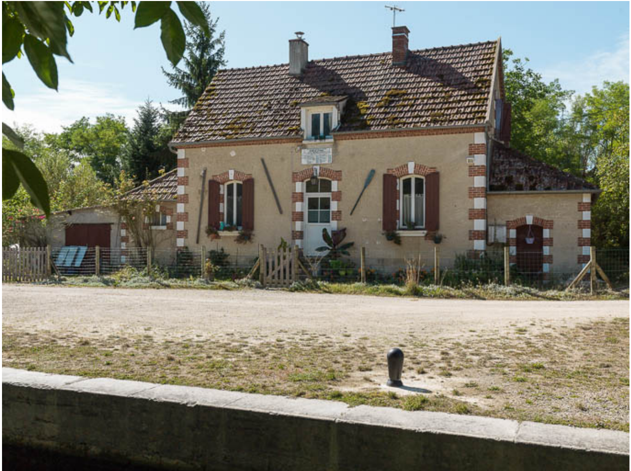
Vue de la maison éclusière.
