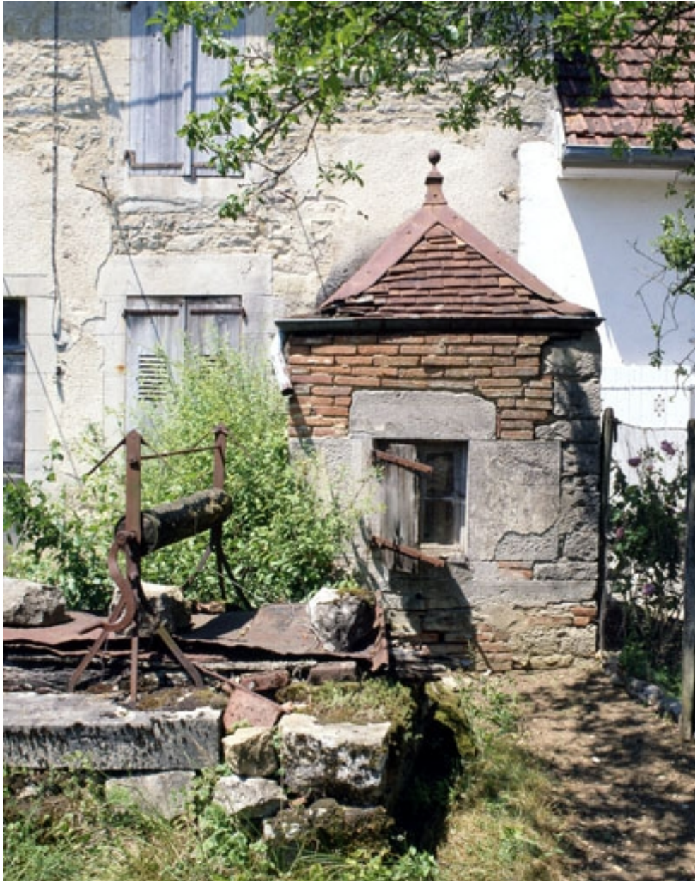
Annexe sur la façade antérieure en 1990.
