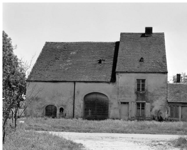
Façade antérieure en 1979. Phot. Bernard Lardière IVR43_19793900350X
