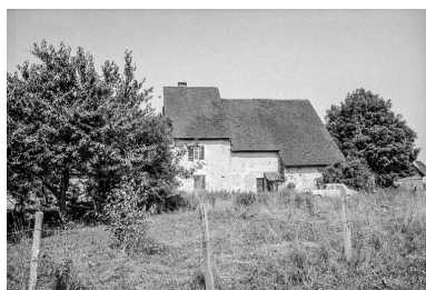
Façade postérieure en 1975. Phot. Bernard Pontefract IVR43_19753900398Z
