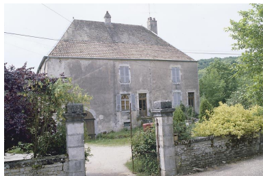
Façade antérieure de l'habitation.
