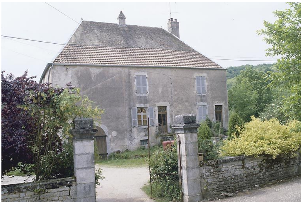
Façade antérieure de l'habitation.
