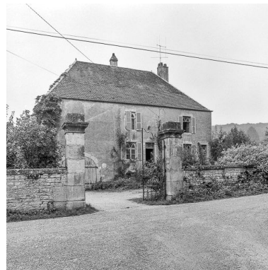
Vue de la partie habitation.
