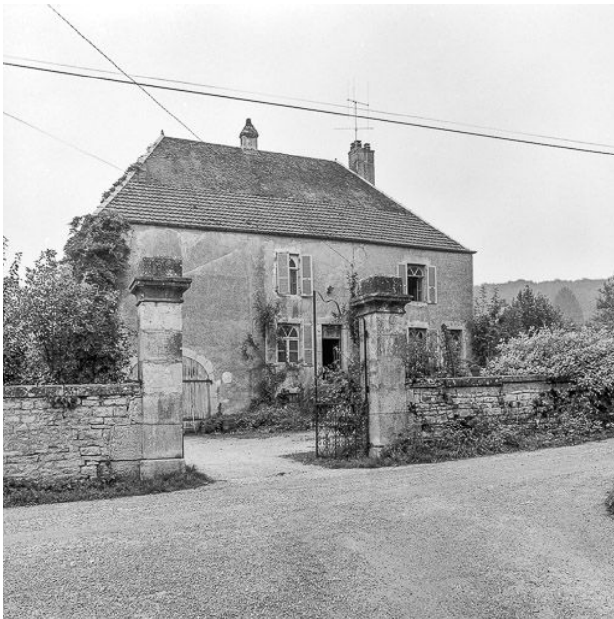
Vue de la partie habitation.
