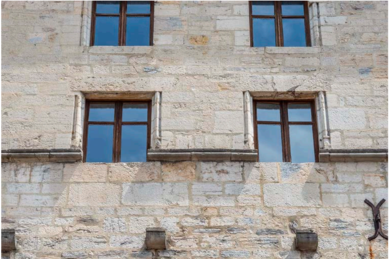
Façade antérieure. Baies des troisièmes et quatrièmes étages.
