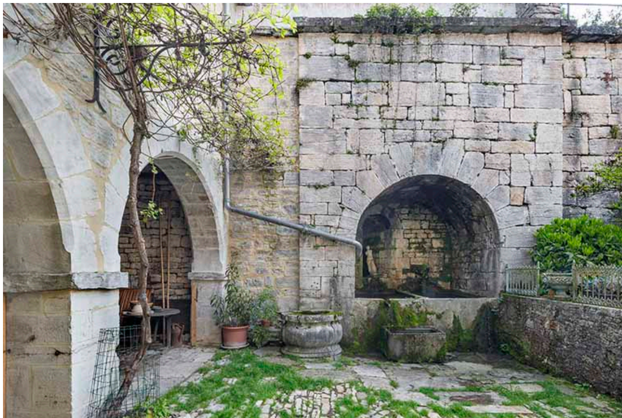
Vivier aménagé dans le mur de la terrasse en terre-plein.
