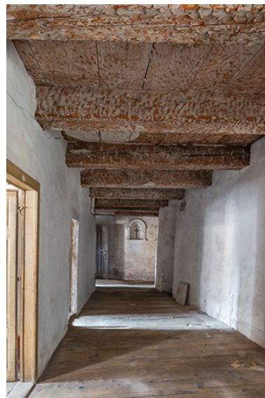
Second étage du bâtiment nord. Le couloir distribuant les cellules des moniales. Phot. Jérôme Mongreville IVR43_20233900384NUC4A
