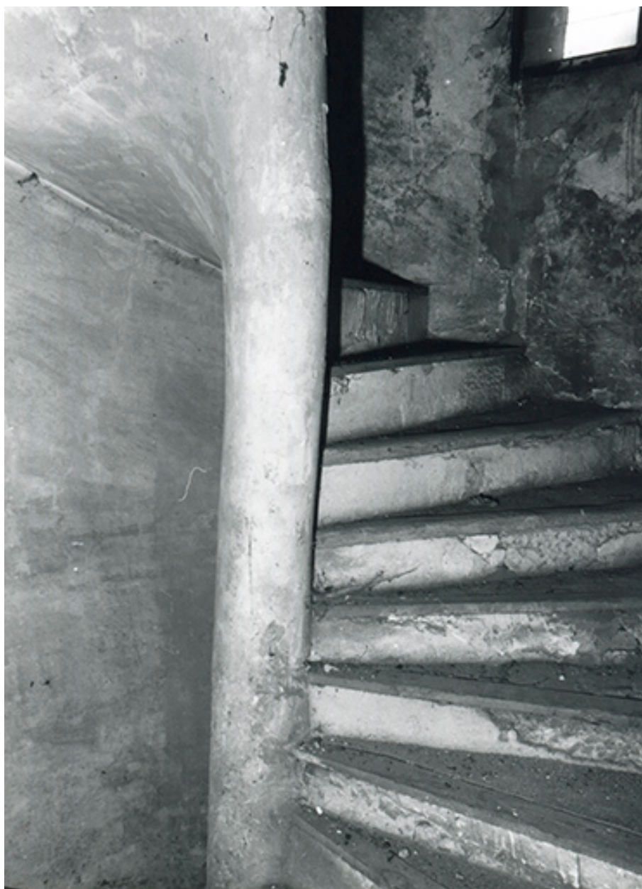
Escalier en vis (jonction entre la maison et l'aile nord du couvent), 1979.
