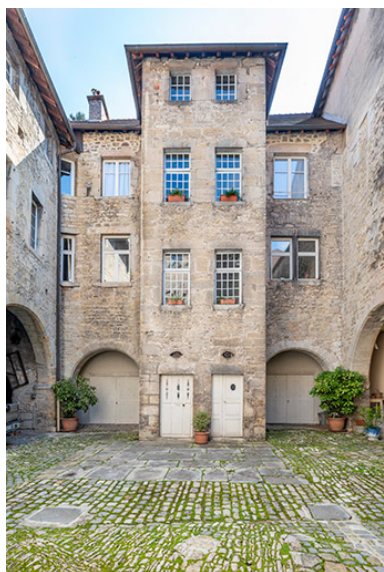
Bâtiment conventuel est. Façade sur cour. Phot. Jérôme Mongreville IVR43_20233900365NUC4A
