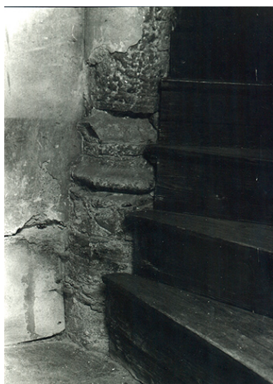
Escalier en vis (jonction entre la maison et l'aile nord du couvent). Base du noyau, 1979. Phot. Patrick Blandin IVR43_20253900053NUC4A
