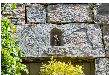
Mur de la terrasse en terre-plein. Linteau supérieur d'un local
