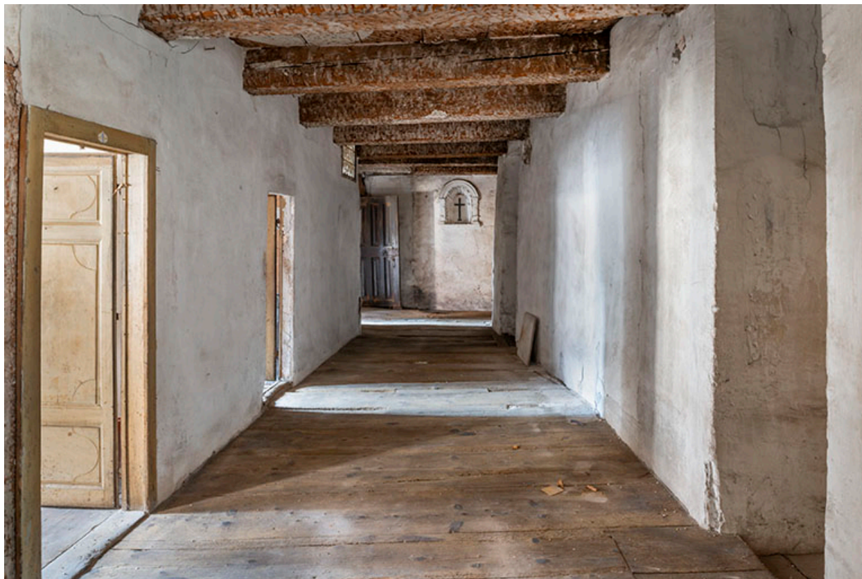
Second étage du bâtiment nord. Le couloir distribuant les cellules des moniales.
