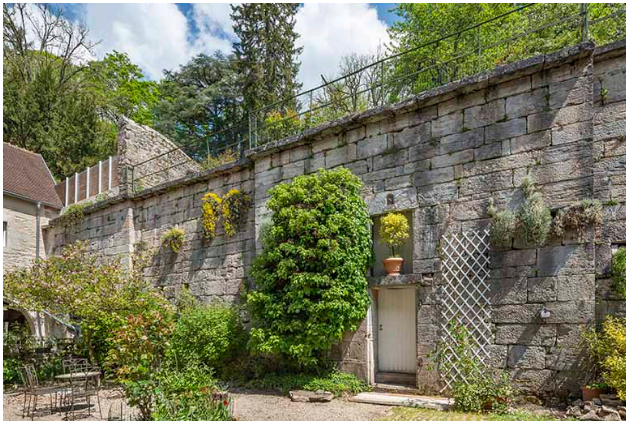
Mur de la terrasse en terre-plein.
