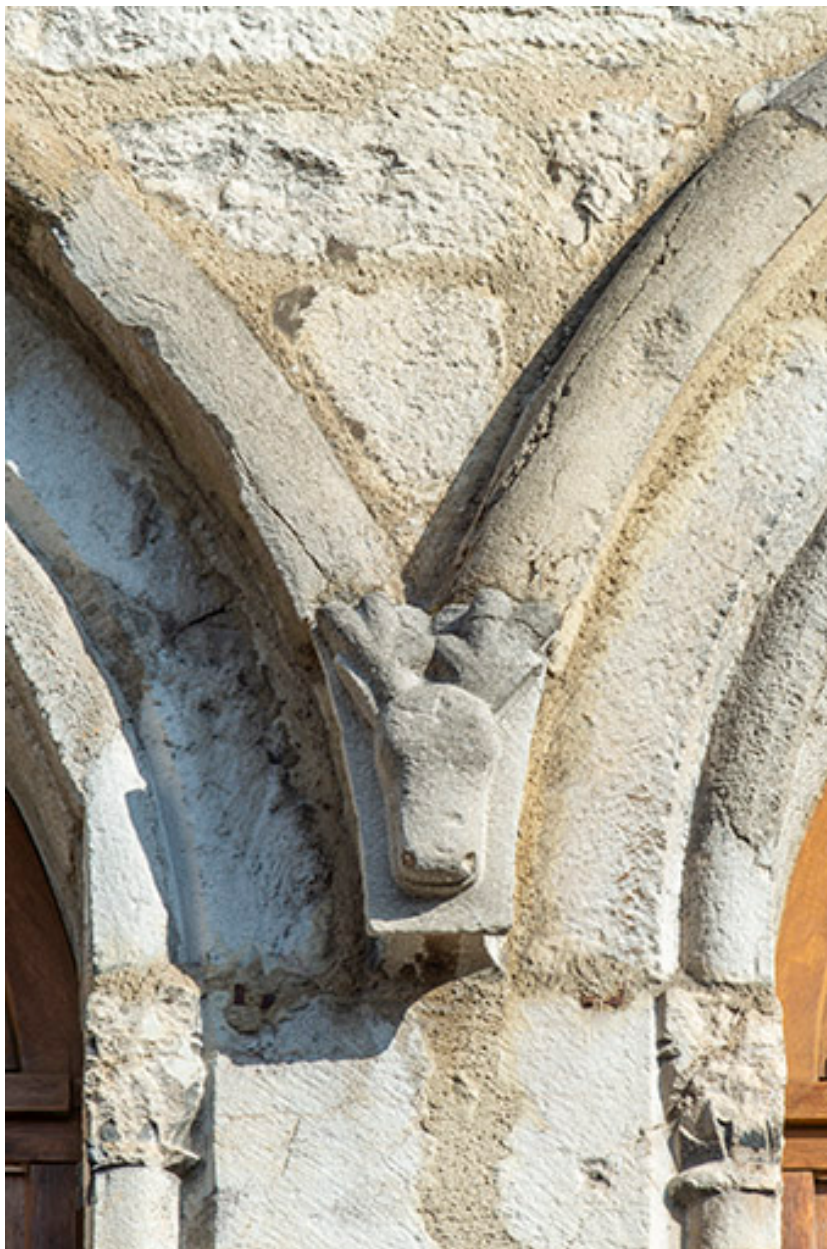
Façade antérieure. Tête sculptée à la retombée des arcs des deux dernières baies.
