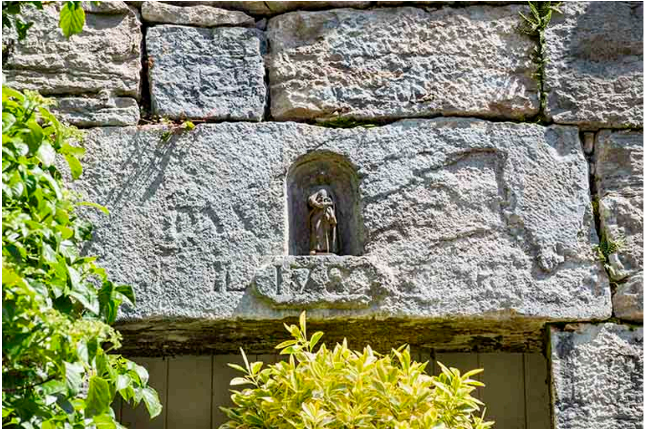
Mur de la terrasse en terre-plein. Linteau supérieur d'un local (glacière, cellier ?) portant une inscription effacée et la date 1782.
