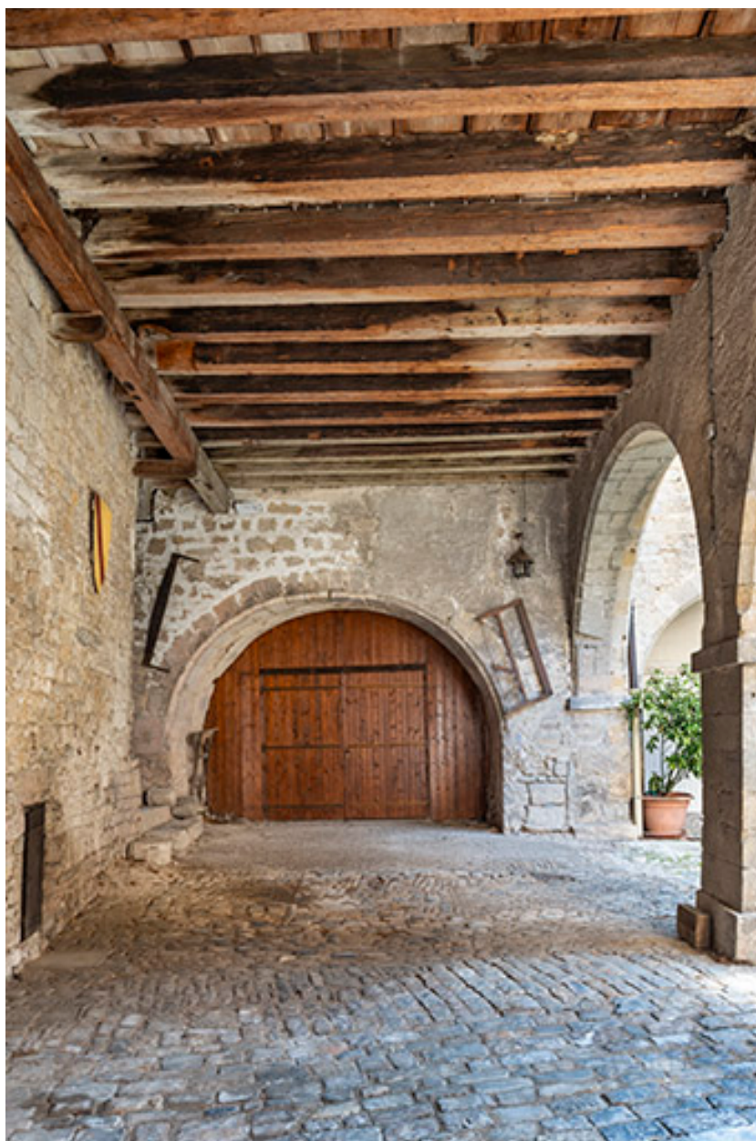
Aile nord. Passage couvert du rez-de-chaussée.
