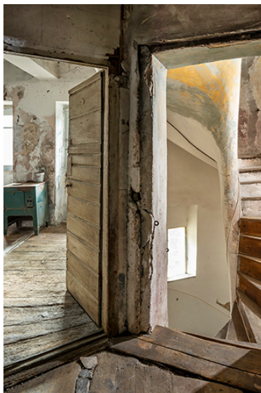
Accès au couloir des cellules depuis la tour. Phot. Jérôme Mongreville IVR43_20233900390NUC4A
