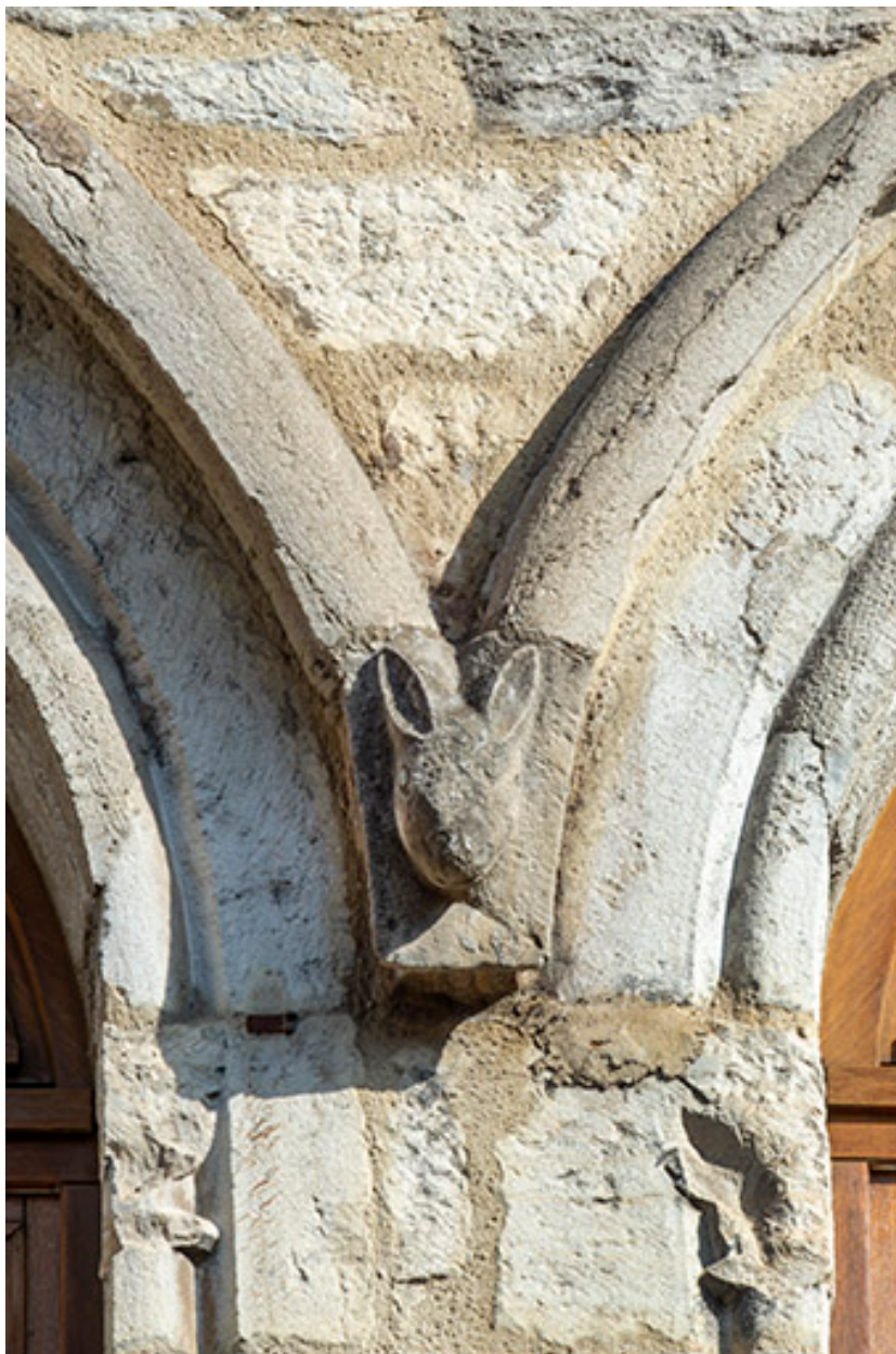
Façade antérieure. Tête sculptée à la retombée des arcs des baies centrales.
