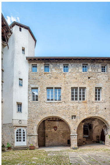
Aile nord. Façade sur cour. Au second étage, les fenêtres des cellules des carmélites. Phot. Jérôme Mongreville IVR43_20233900377NUC4A
