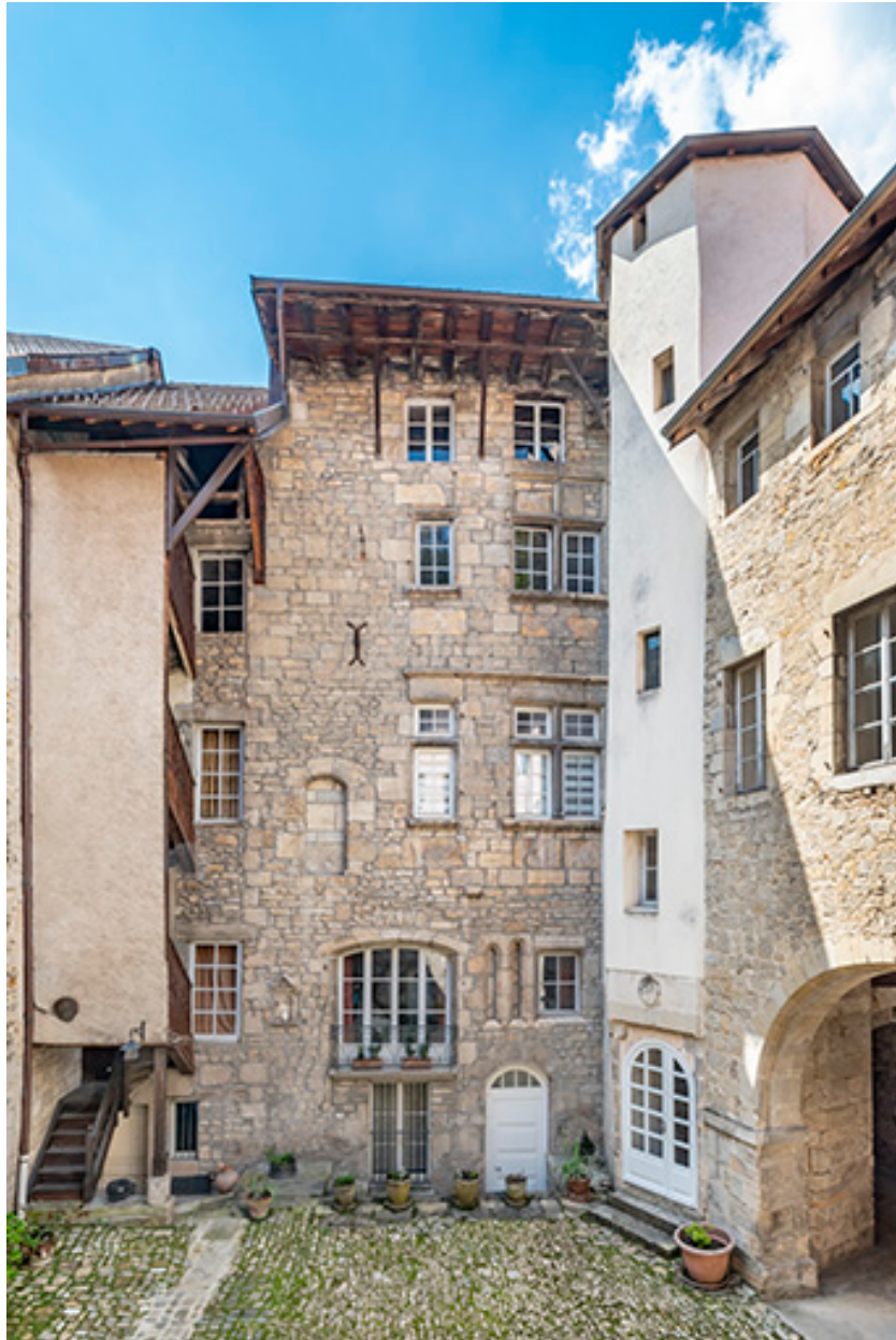
Bâtiment sur rue. Elévation de la façade postérieure, et tour d'escalier polygonale au joignant du bâtiment conventuel nord.
