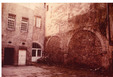
Mur sud de la cour, où apparaissent les grandes baies cintrées, symétriques à celles du mur nord, 1985. Phot. Patrick Blandin IVR43_20253900056NUC4A
