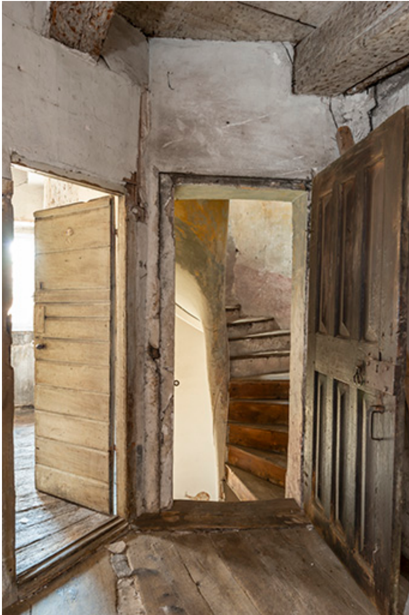
Entrée du couloir depuis la tour polygonale.
