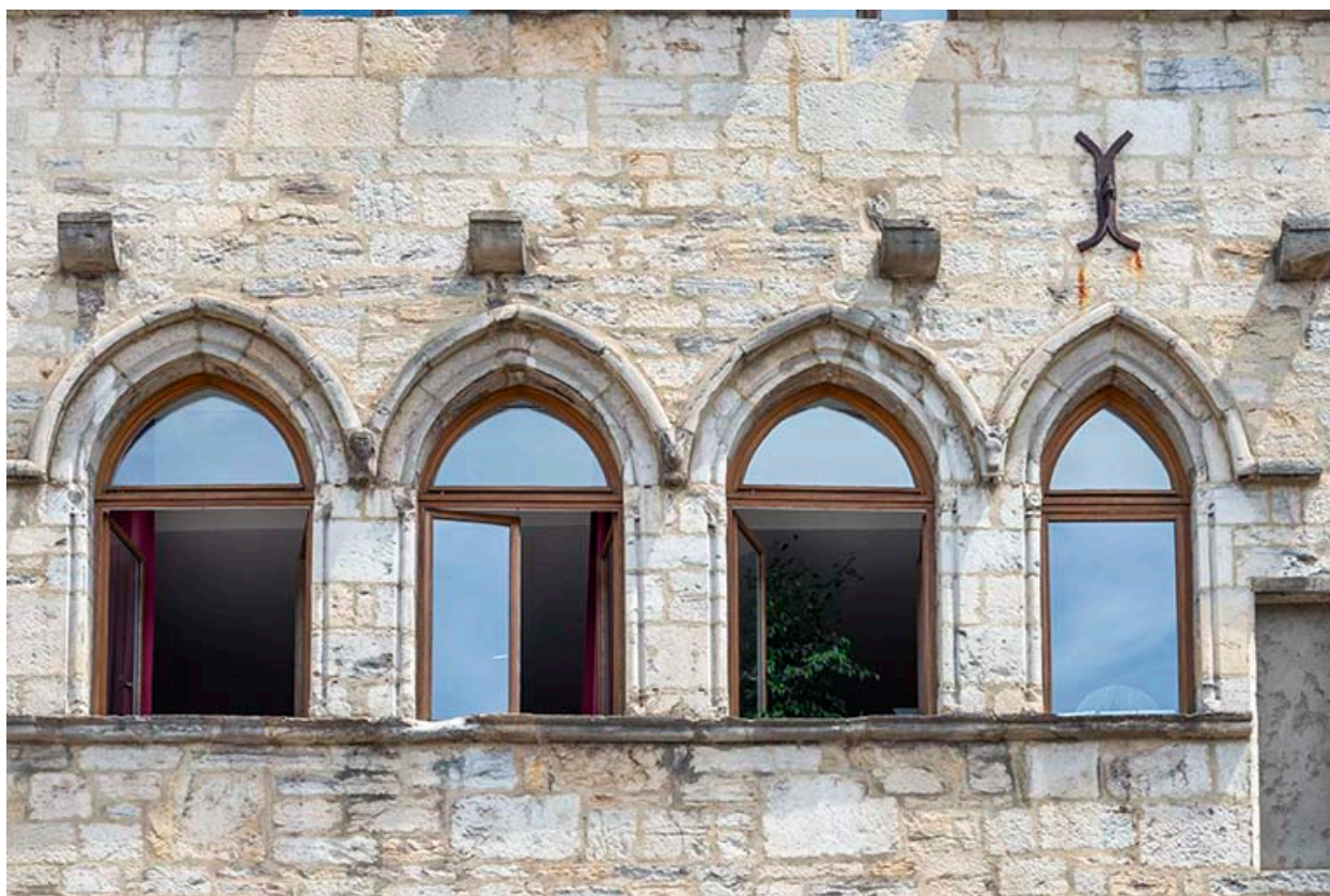
Façade antérieure. Baies du deuxième étage.
