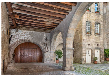
La cour depuis le passage couvert nord. Phot. Jérôme Mongreville IVR43_20233900371NUC4A
