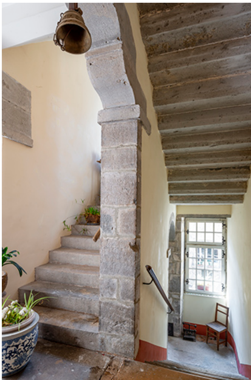
Bâtiment conventuel est. Escalier.
