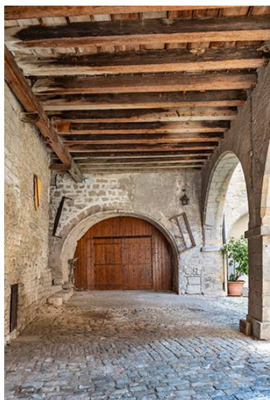
Aile nord. Passage couvert du rez-de-chaussée. Phot. Jérôme Mongreville IVR43_20233900370NUC4A
