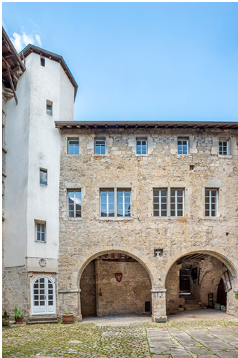
Aile nord. Façade sur cour. Au second étage, les fenêtres des cellules des carmélites.
