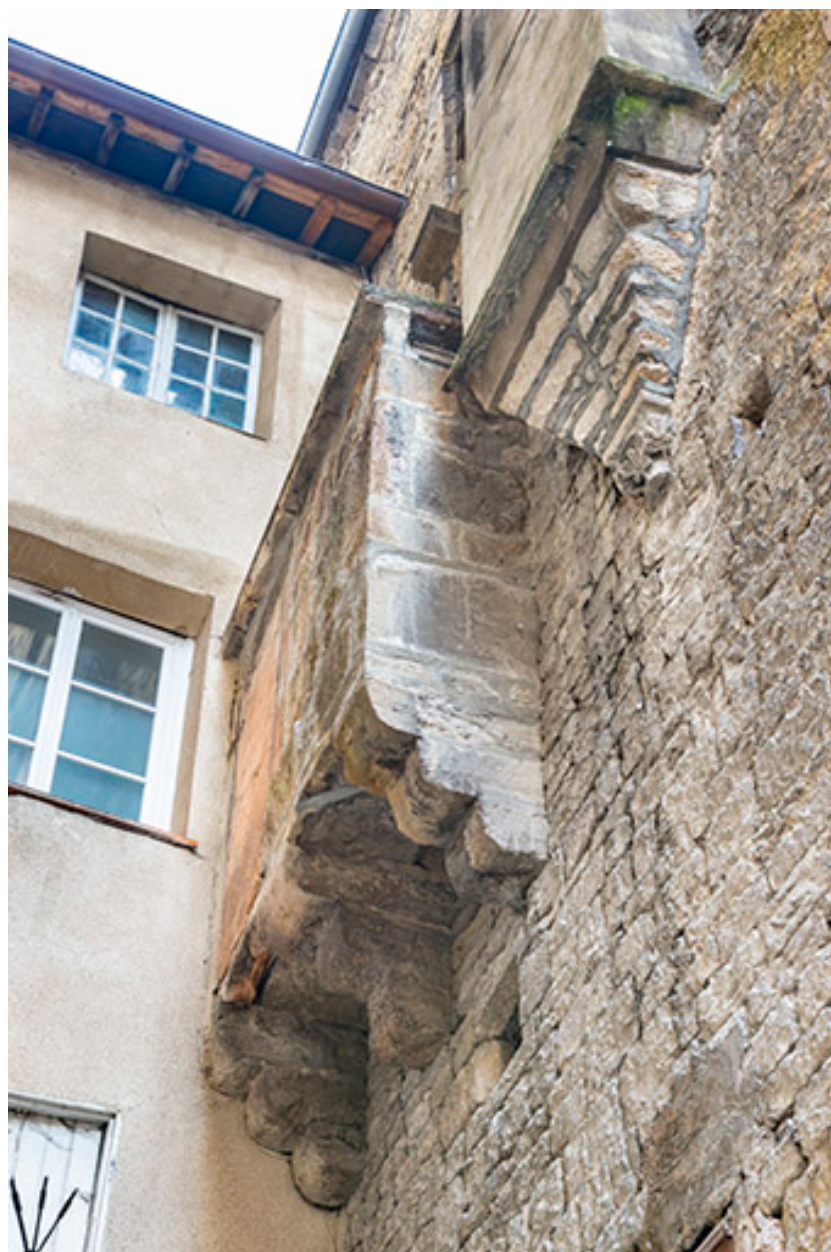
Bretèche et partie en encorbellement sur le mur nord du bâtiment sur rue.
