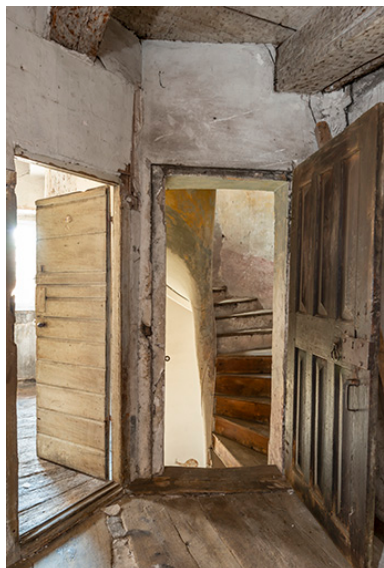
Entrée du couloir depuis la tour polygonale. Phot. Jérôme Mongreville IVR43_20233900388NUC4A
