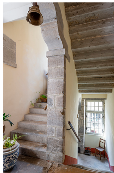
Bâtiment conventuel est. Escalier. Phot. Jérôme Mongreville IVR43_20233900375NUC4A
