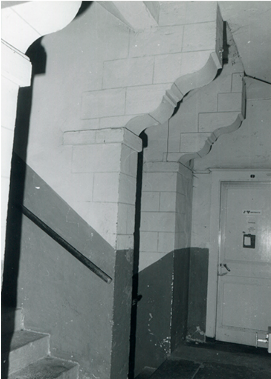
Consoles de l'escalier du couvent, 1985.
