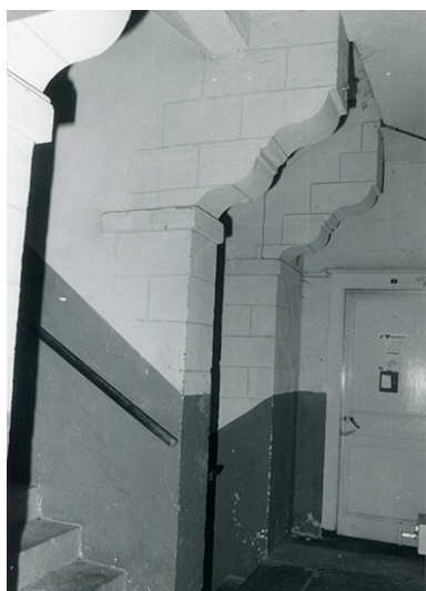
Consoles de l'escalier du couvent, 1985. Phot. Patrick Blandin IVR43_20253900057NUC4A
