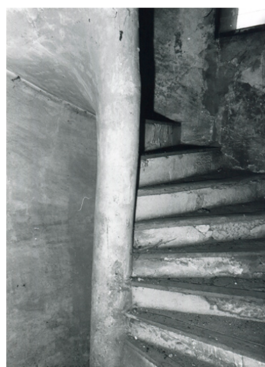
Escalier en vis (jonction entre la maison et l'aile nord du couvent), 1979. Phot. Patrick Blandin IVR43_20253900054NUC4A
