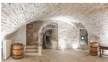
Caveau de dégustation aménagé dans la casemate supérieure de la tour sud-ouest. Phot. Pierre-Marie Barbe-Richaud IVR26_20142101397NUC4AQ
