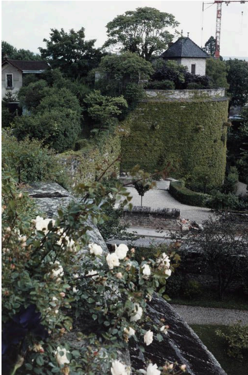
Tour nord-est et courtine est : vue d'ensemble prise depuis la plateforme de la tour sud-est (1988).
