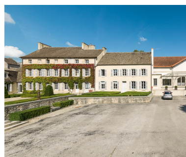
Façade antérieure des bureaux, installés sur l'ancienne esplanade du château. Phot. Pierre-Marie Barbe-Richaud IVR26_20142101355NUC4AQ
