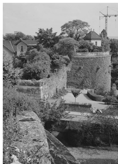
Tour nord-est et courtine est : vue d'ensemble prise depuis la plateforme de la tour sud-est (1988).
