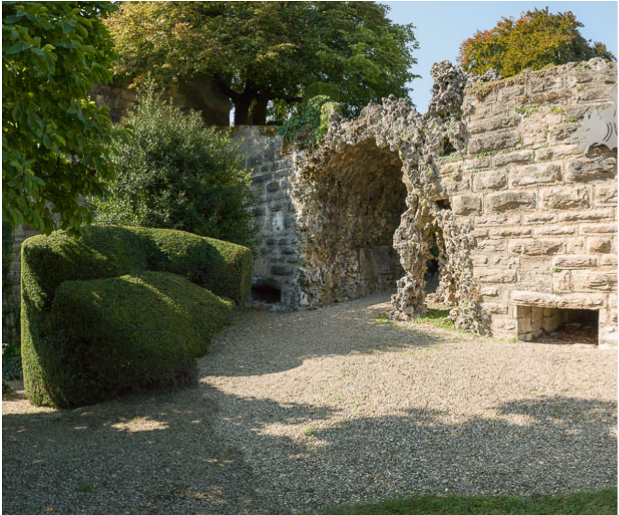
Passage aménagé dans l'ancienne courtine.
