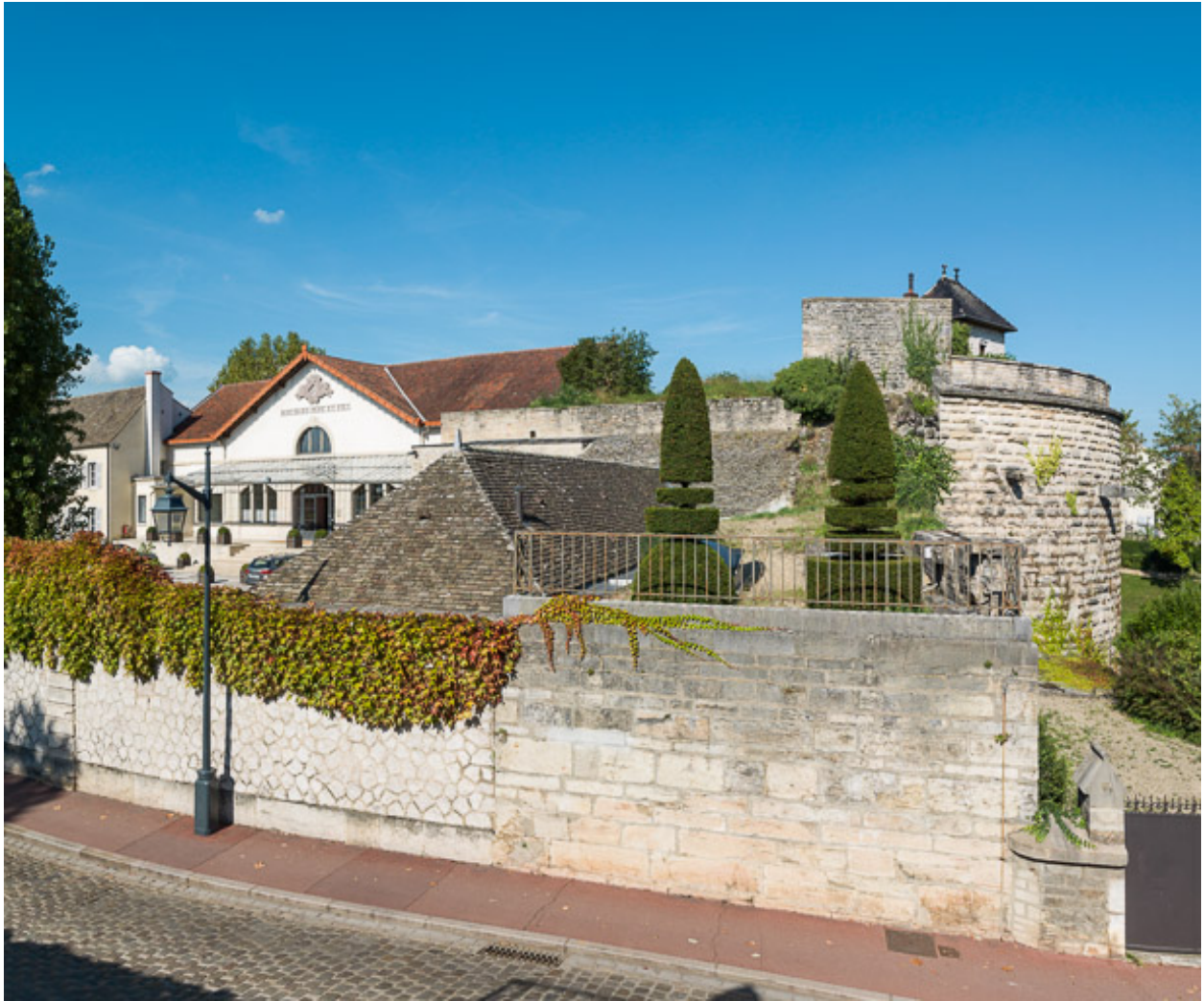
vestiges des remparts et rue du Château.
