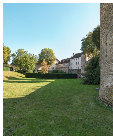
Anciens fossés du château et base de la tour Blondeau. Phot. Pierre-Marie Barbe-Richaud IVR26_20142101363NUC2A
