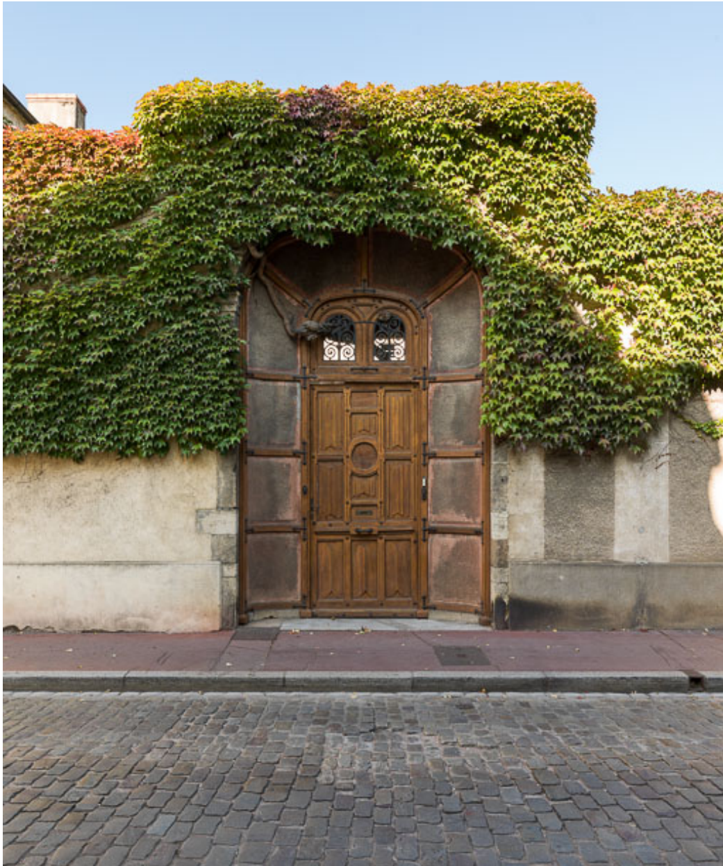
Mur de clôture et porte rue du Château.
