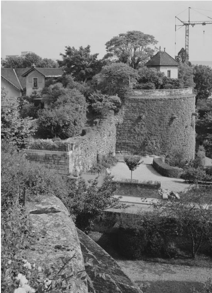
Tour nord-est et courtine est : vue d'ensemble prise depuis la plateforme de la tour sud-est (1988).
