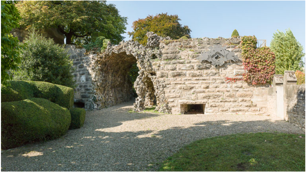
Passage aménagé dans l'ancienne courtine.
