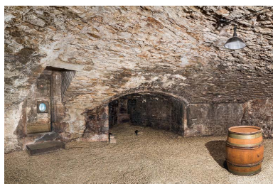
Casemate inférieure de la tour sud-ouest. Phot. Pierre-Marie Barbe-Richaud IVR26_20142101399NUC4AQ
