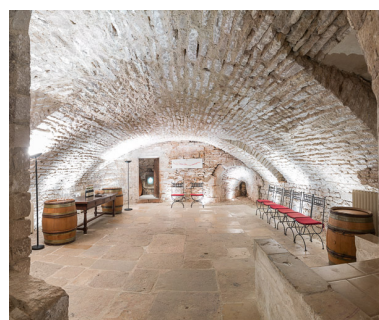
Caveau de dégustation aménagé dans la casemate supérieure de la tour sud-ouest. Phot. Pierre-Marie Barbe-Richaud IVR26_20142101398NUC4AQ
