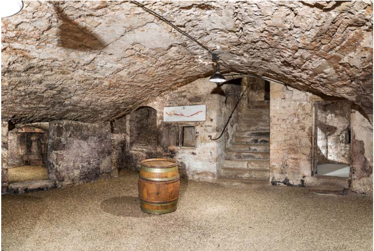
Casemate inférieure de la tour sud-ouest.
