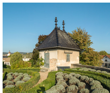
Le pavillon de jardin. Phot. Pierre-Marie Barbe-Richaud IVR26_20142101369NUC4AQ
