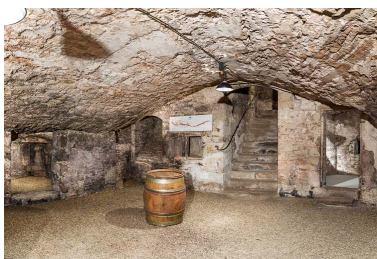
Casemate inférieure de la tour sud-ouest. Phot. Pierre-Marie Barbe-Richaud IVR26_20142101400NUC4AQ
