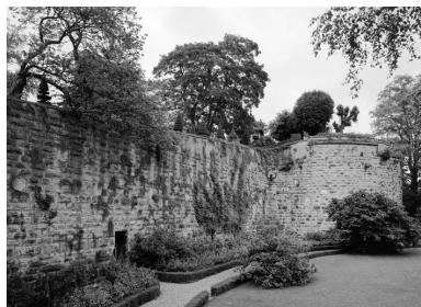
Escarpe de la courtine sud : vue d'ensemble prise du sud-ouest (1988).
