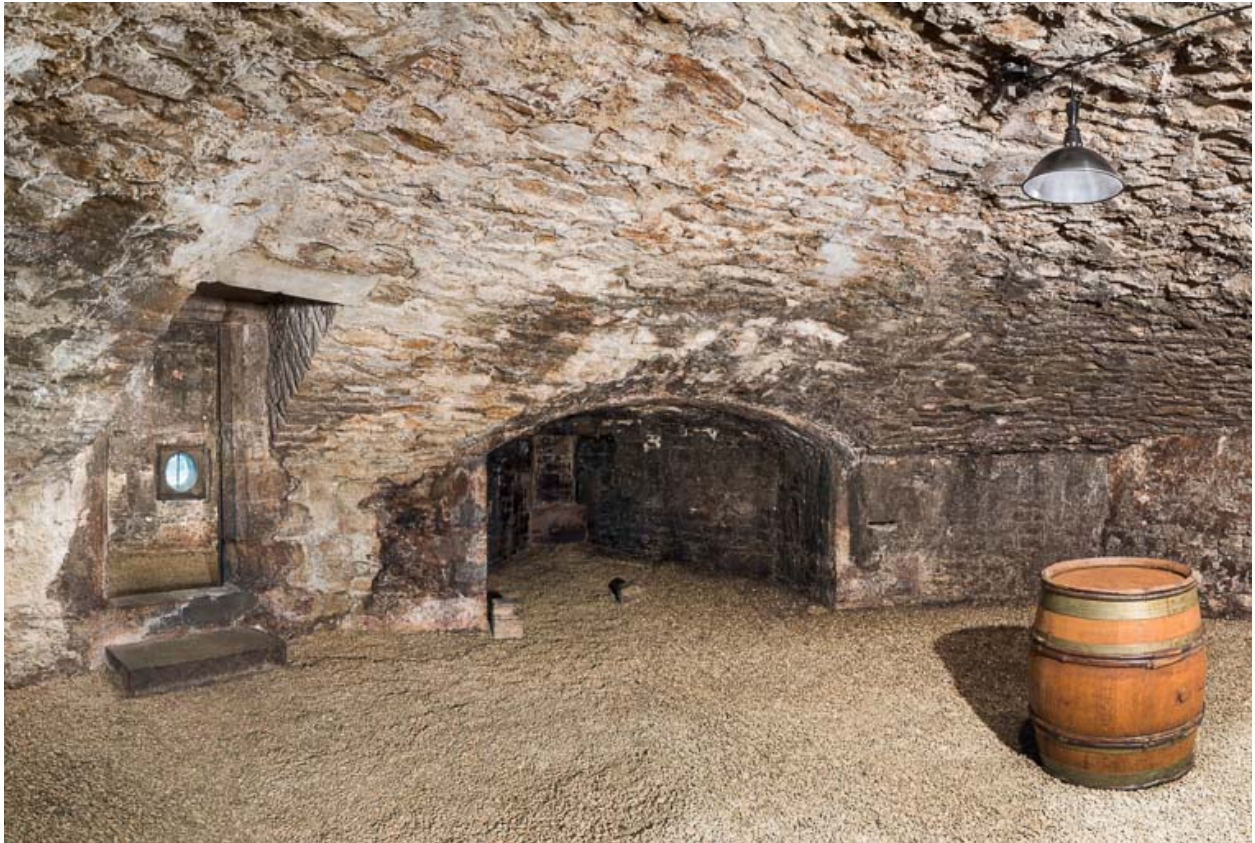
Casemate inférieure de la tour sud-ouest.
