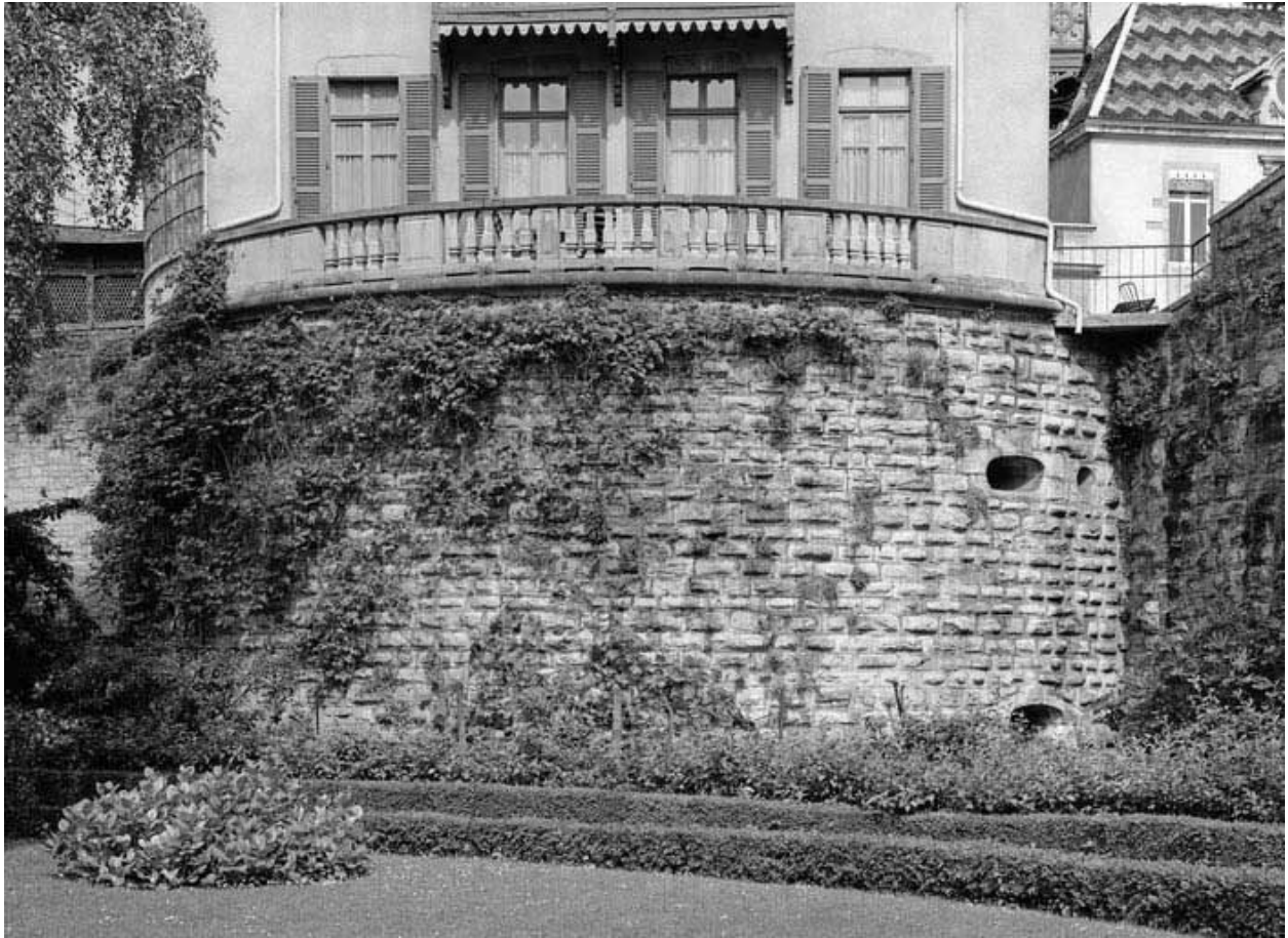
Tour sud-ouest depuis le fossé (1988).
