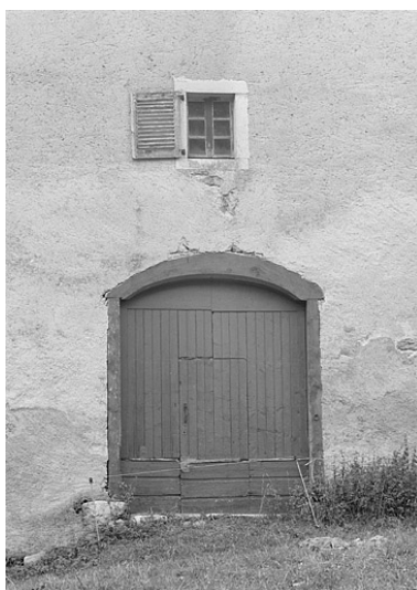
Accès à la grange haute. Phot. Jérôme Mongreville IVR43_19963901379X
