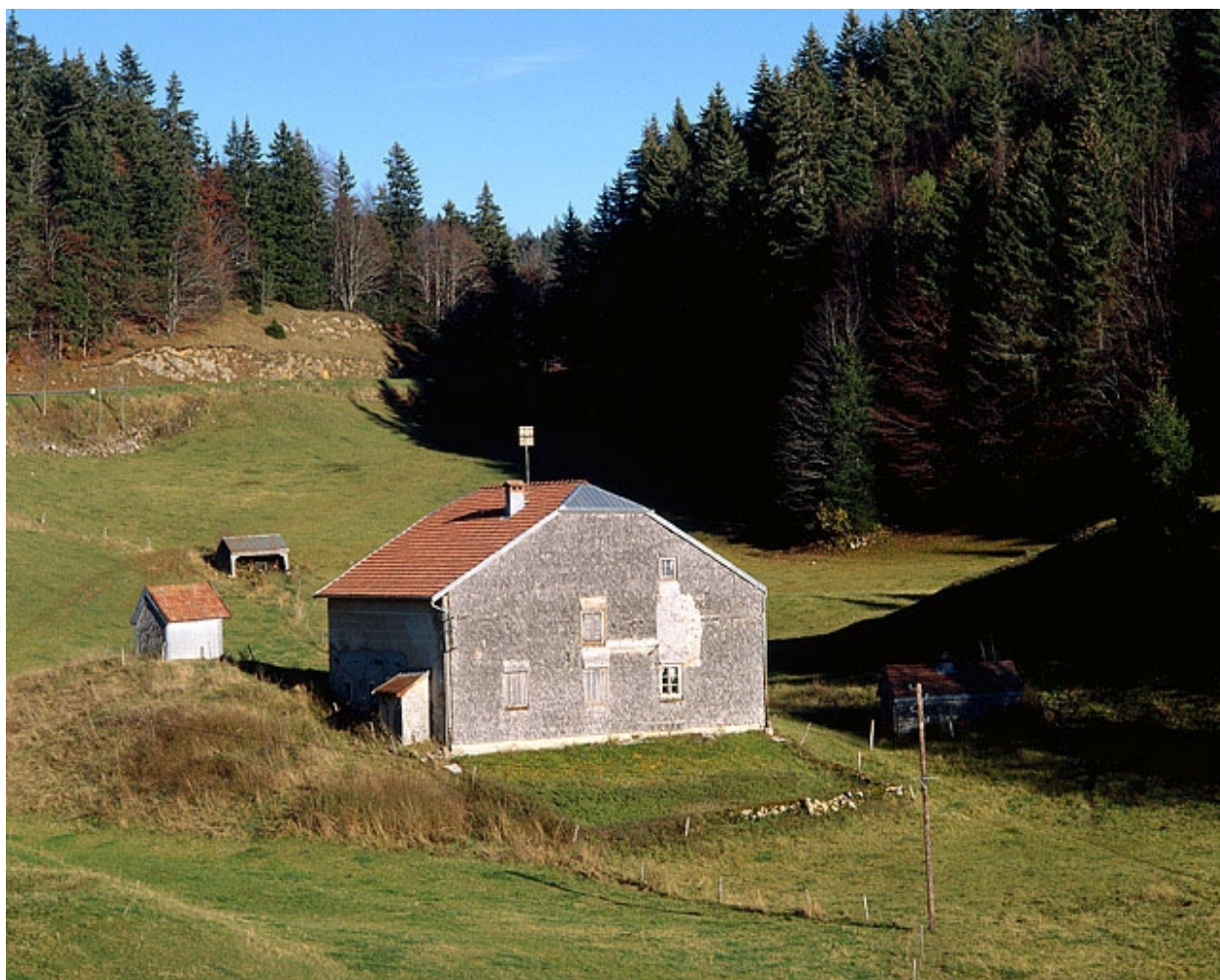
Vue générale depuis le sud-ouest.
