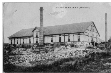
Tuilerie de Baulay. Phot. Jérôme Mongreville IVR43_20167001503NUC4A
