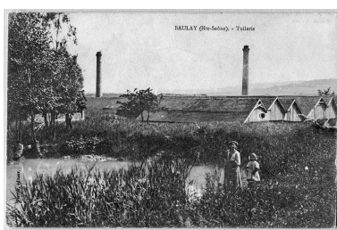
Tuilerie de Baulay. Phot. Jérôme Mongreville IVR43_20167001496NUC4A
