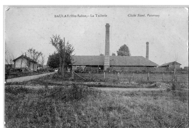
Tuilerie de Baulay. Phot. Jérôme Mongreville IVR43_20167001495NUC4A
