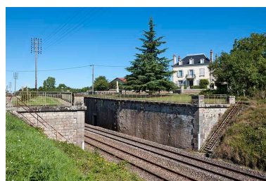
Maison située de l'autre côté de la tranchée de la voie ferrée. Phot. Jérôme Mongreville IVR43_20167001374NUC4A
