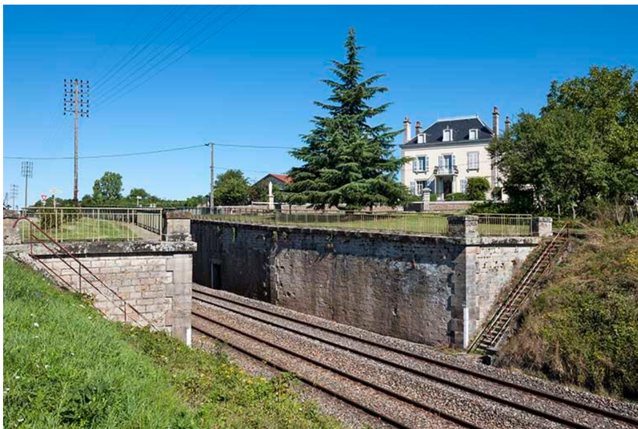
Maison située de l'autre côté de la tranchée de la voie ferrée.
