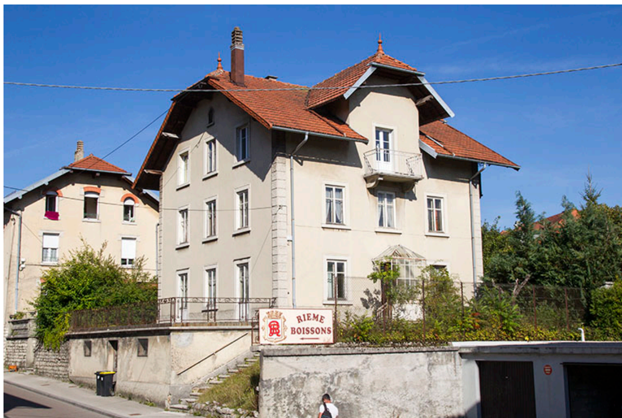
Façades antérieure et latérale droite.
