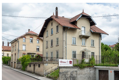
Vue d'ensemble rapprochée, depuis le sud-ouest. Phot. Sonia Dourlot IVR43_20182500960NUC4A
