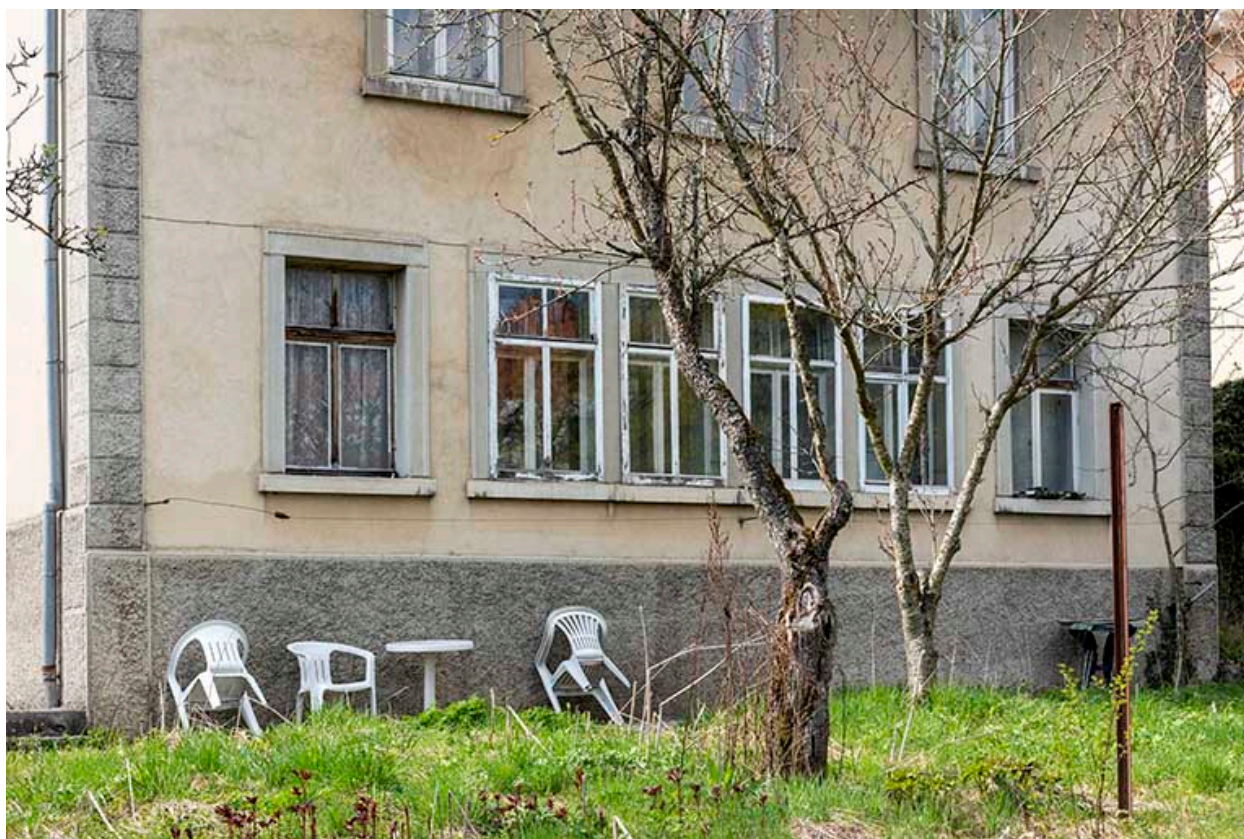
Façade postérieure : fenêtres multiples de l'atelier.
