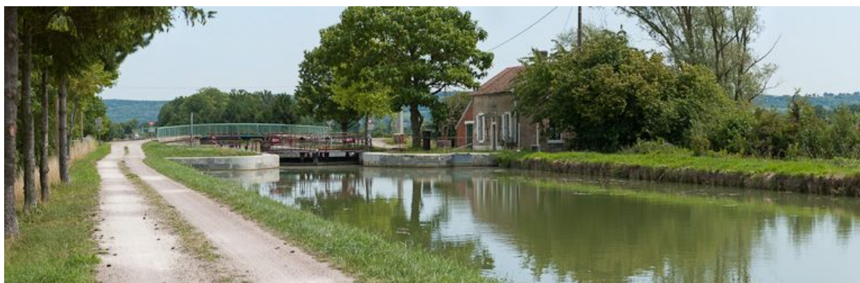
Vue d'ensemble du site d'écluse.
