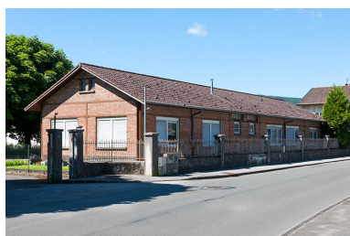
Bâtiment des logements et bureau.
