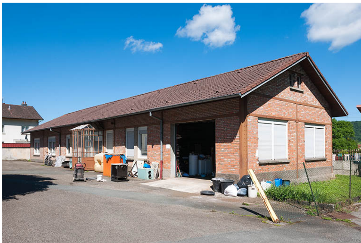
Logements et bureau vus de trois quarts.
