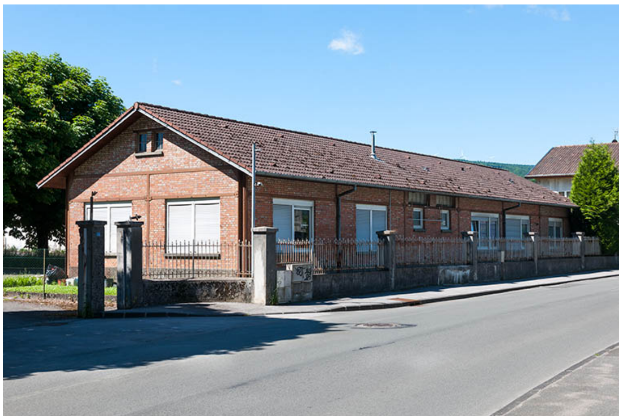
Bâtiment des logements et bureau.
