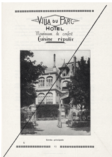
Entrée principale. Autr. auteur inconnu IVR43_20232500620NUC2A
