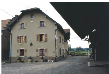
La minoterie et son logement depuis l'ouest. Phot. Yves Sancey IVR43_20009000120ZA
