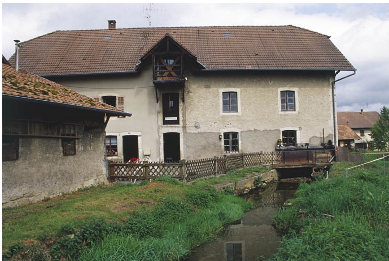
Façade antérieure de la minoterie.
