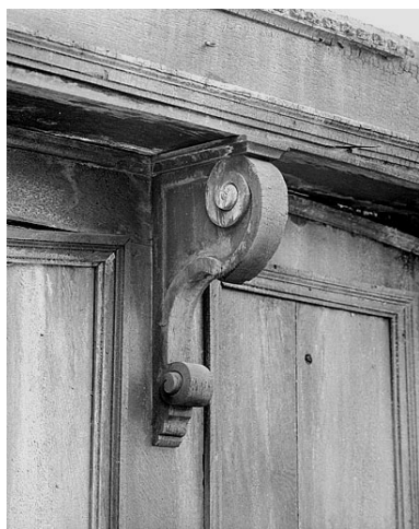
Détail d'une console soutenant le dais des dorsaux du mur sud du chœur, après l'incendie de 1987. Phot. Jérôme Mongreville IVR43_19872500874X
