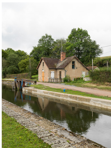
Vue du site et de la maison éclusière. Phot. Pierre-Marie Barbe-Richaud IVR26_20175800281NUC2A
