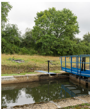
Vue du sas. Phot. Pierre-Marie Barbe-Richaud IVR26_20175800282NUC2A
