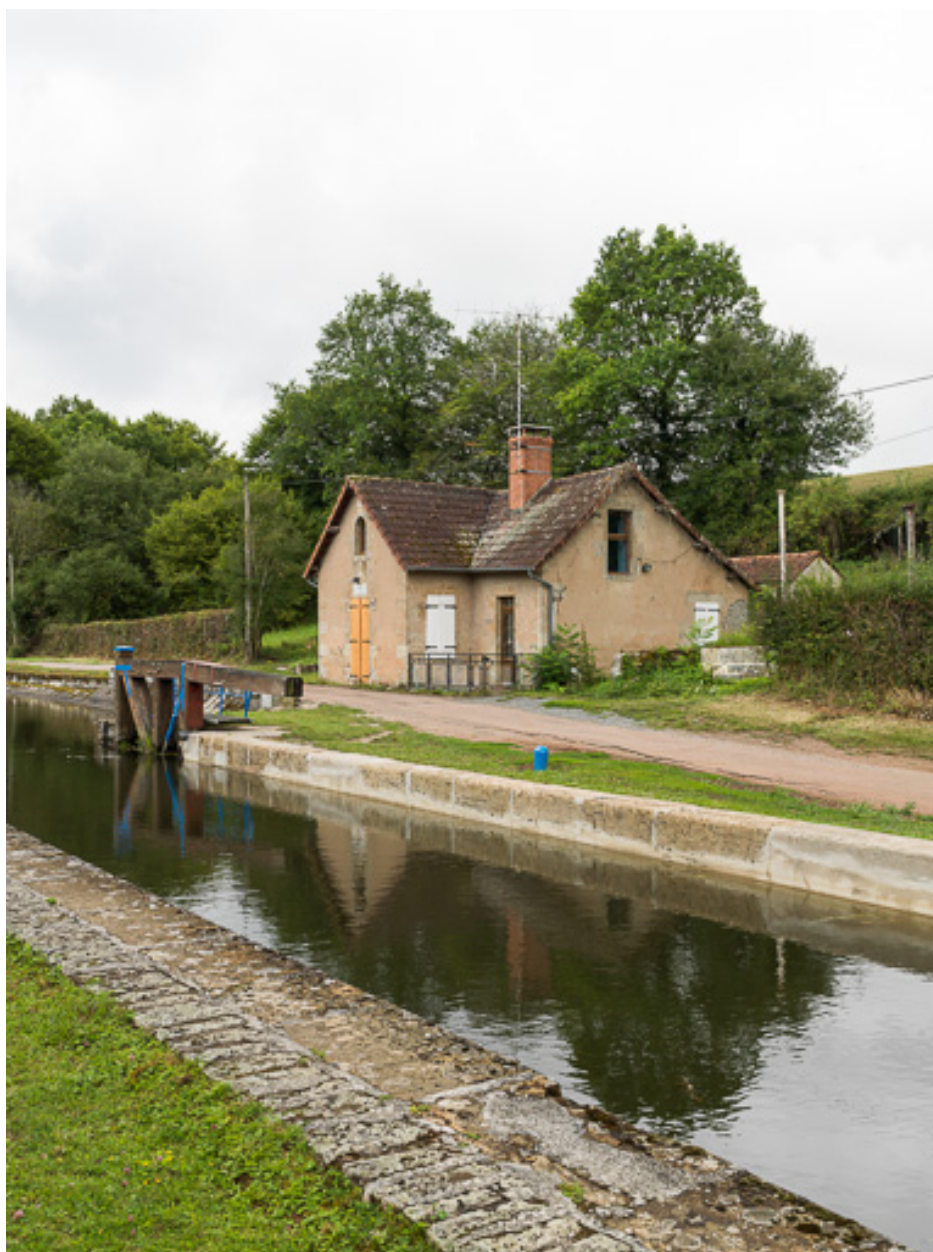
Vue du site et de la maison éclusière.
