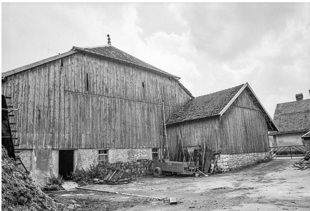
Pignon postérieur de la partie agricole.
