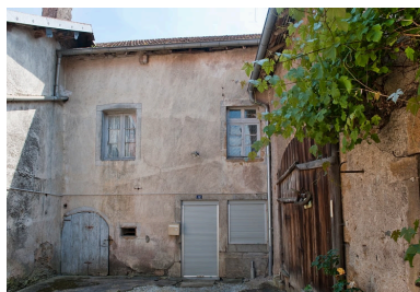
Façade antérieure. Phot. Jérôme Mongreville IVR43_20102501045NUC4A
