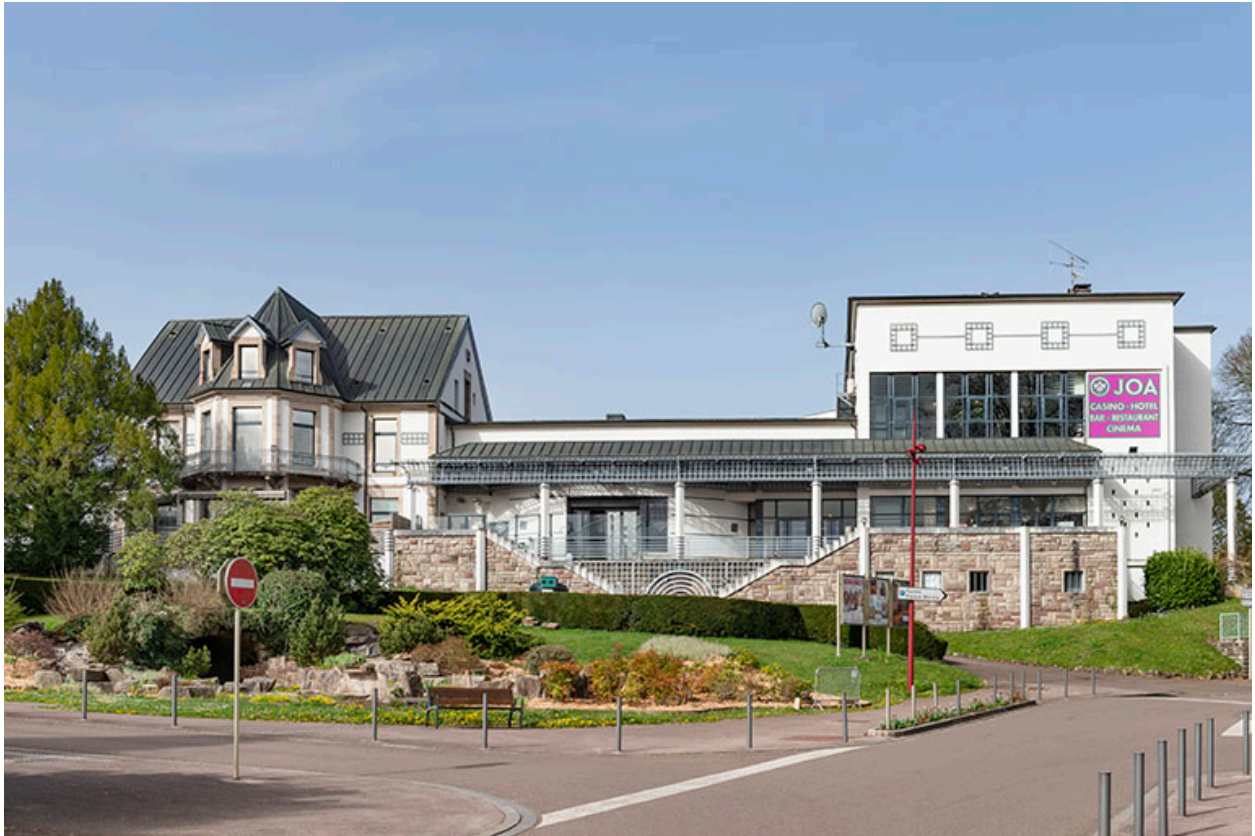
Vue d'ensemble avec la maison (à gauche) et la salle des fêtes (à droite).
