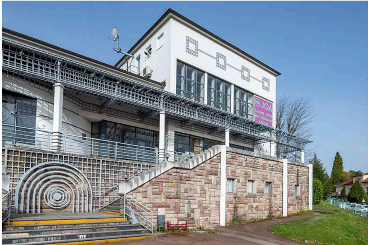
Salle des fêtes, vue depuis le sud-ouest.
