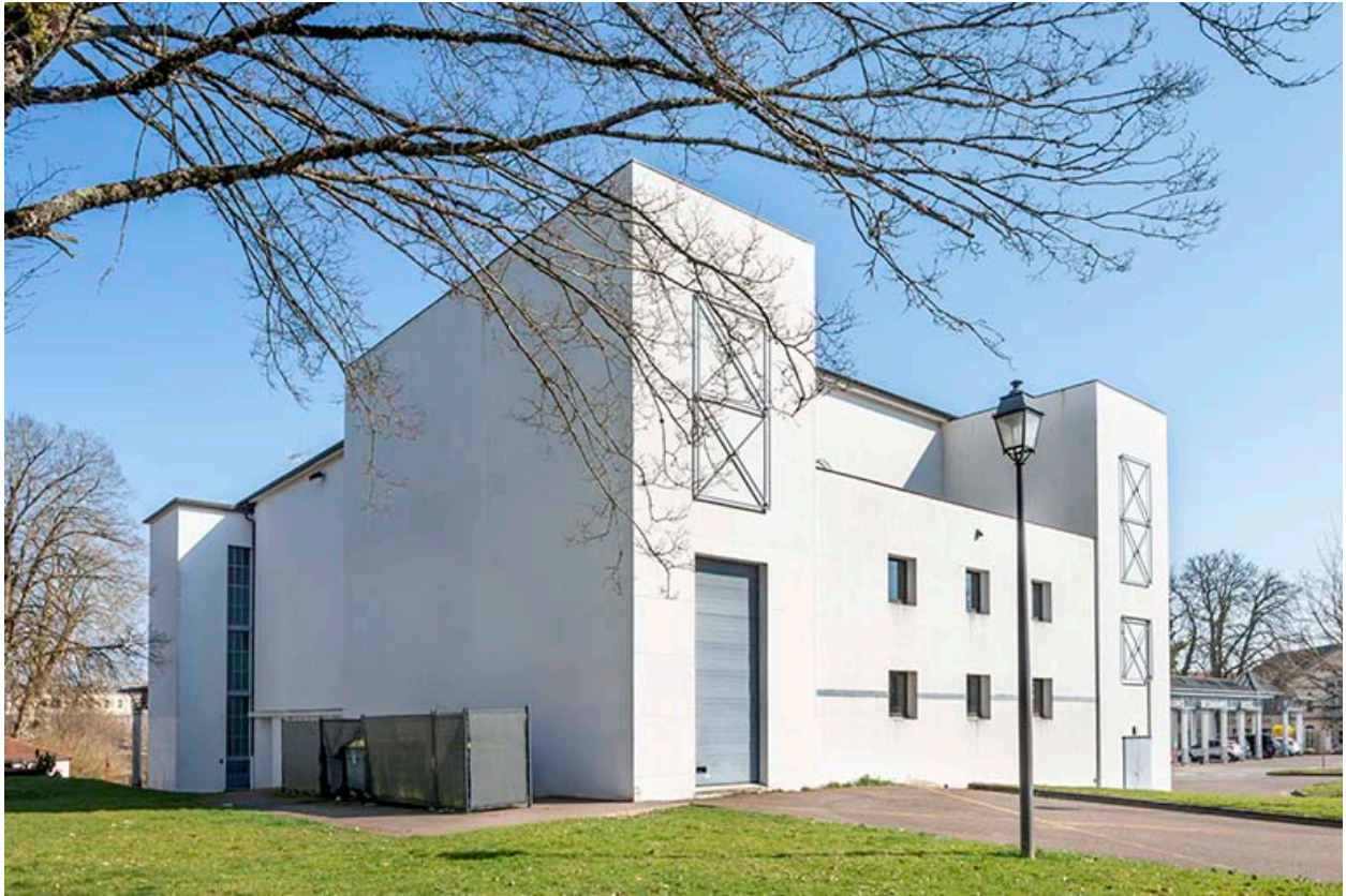
Salle des fêtes, vue depuis le nord-ouest.
