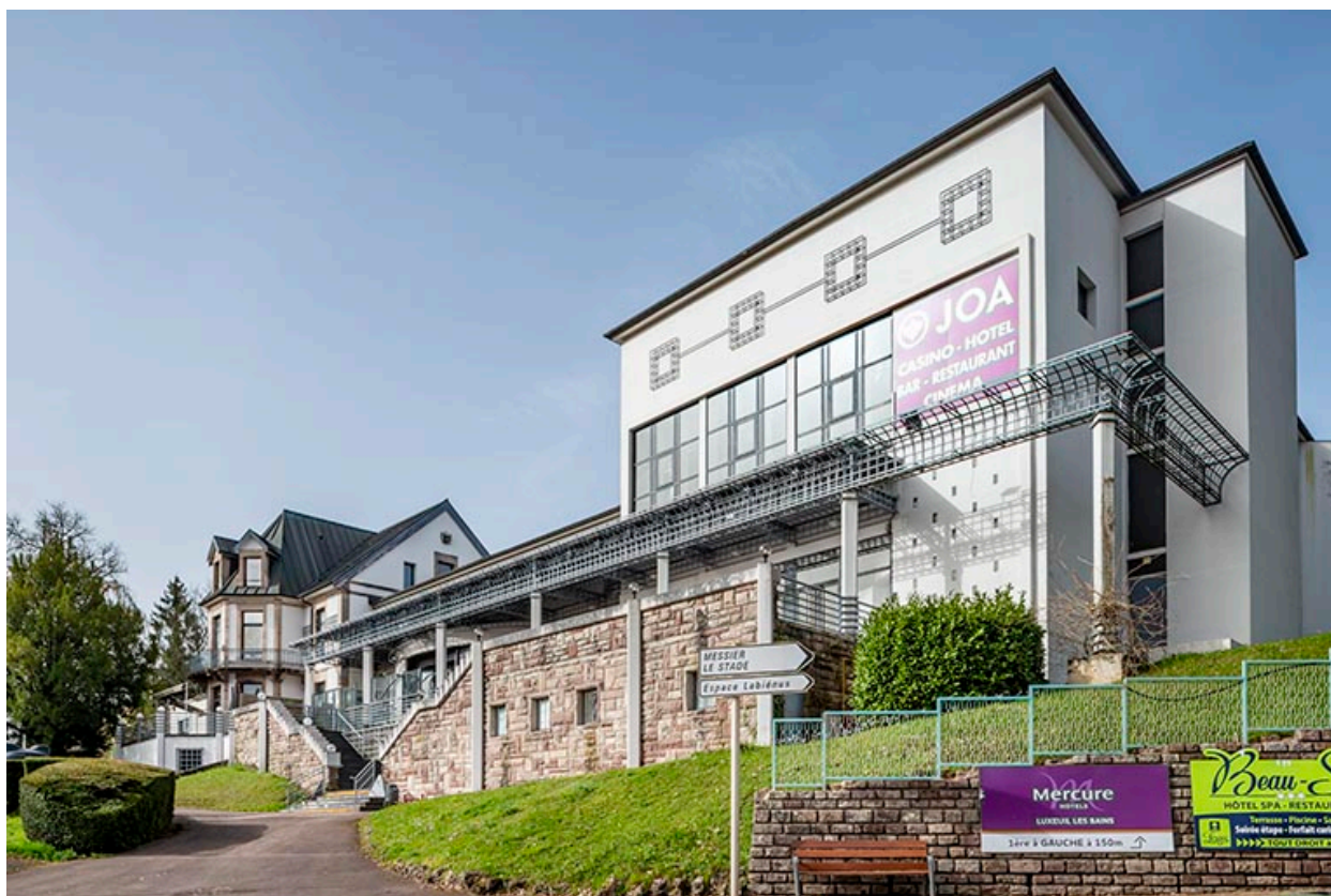
Salle des fêtes, vue depuis le nord-ouest.
