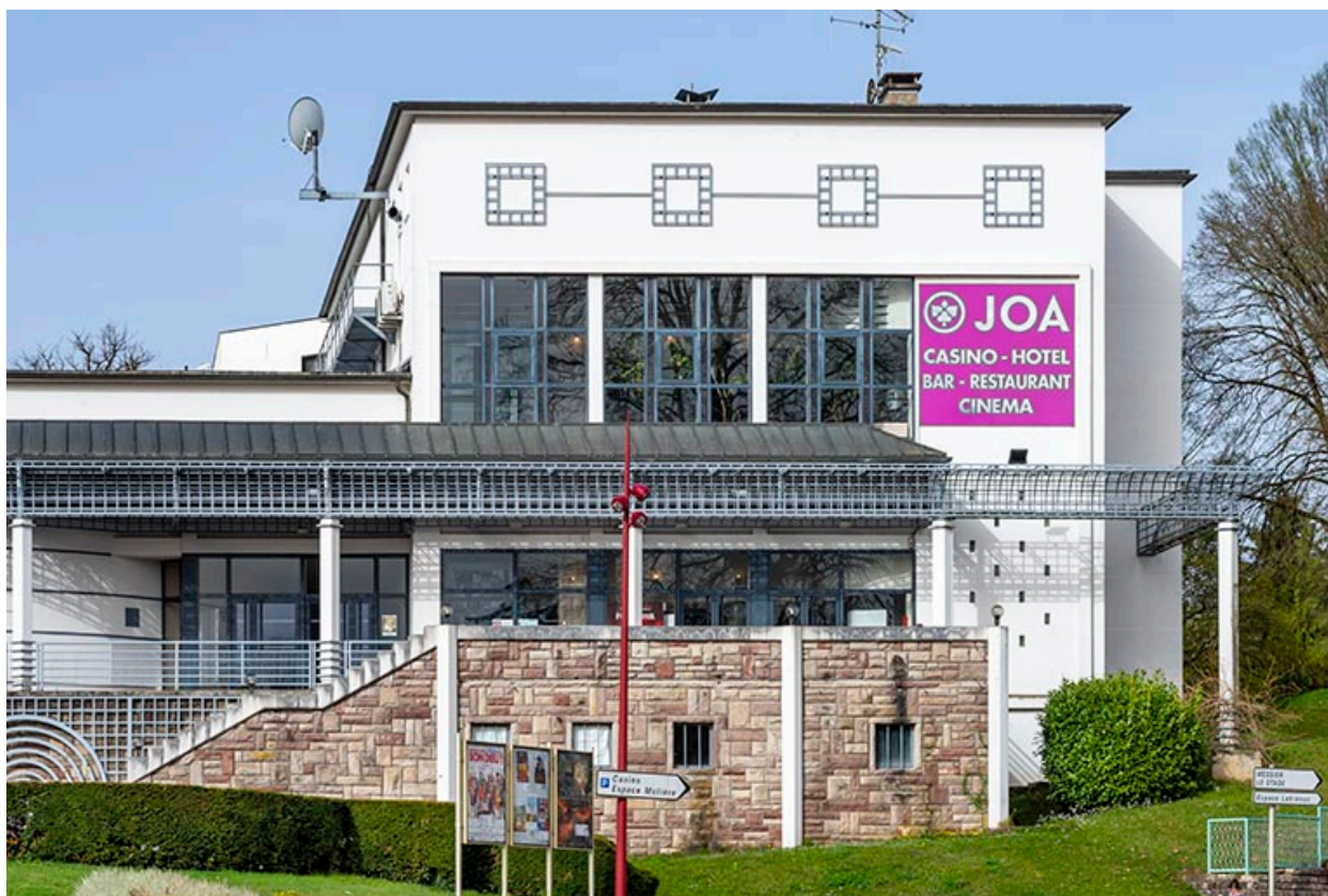
Salle des fêtes, vue depuis l'ouest.
