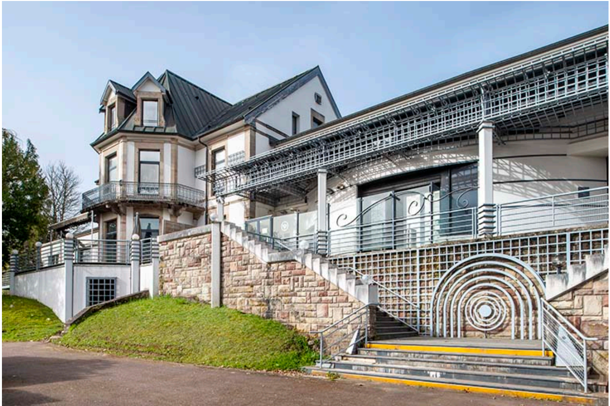
Corps de bâtiment liant la maison (à gauche) et la salle des fêtes (à droite).
