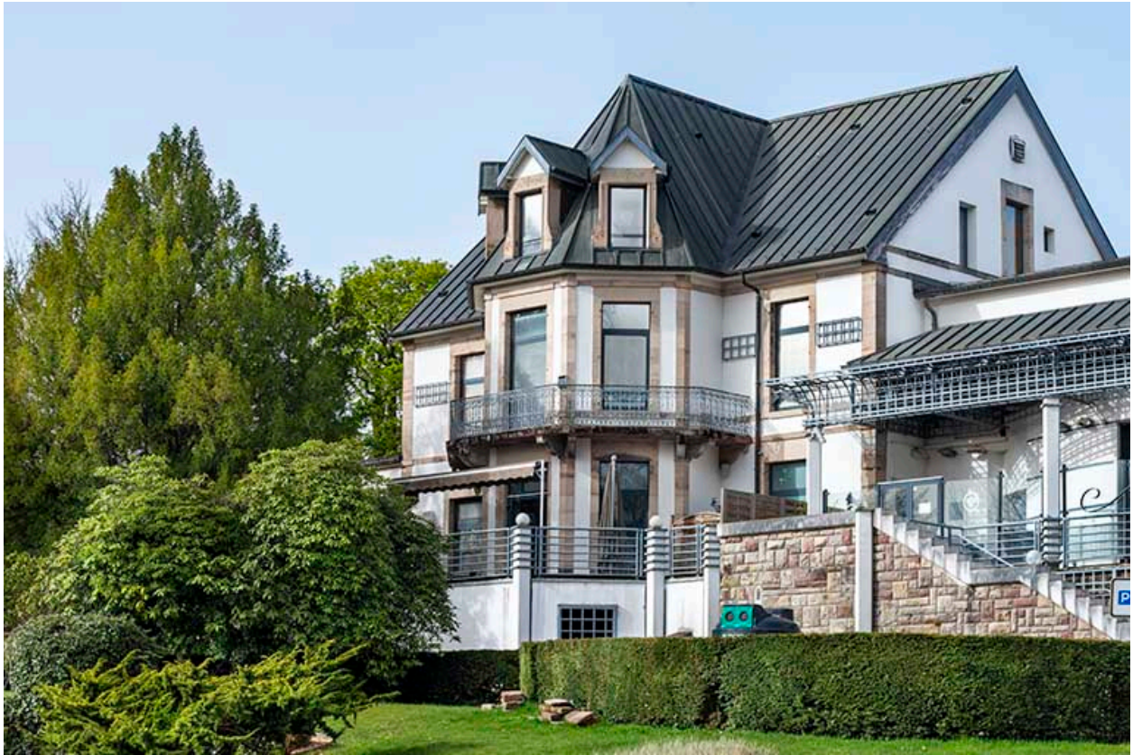
Maison, vue depuis le nord.
