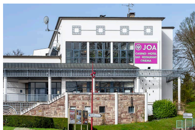
Salle des fêtes, vue depuis l'ouest. Phot. Jérôme Mongreville IVR43_20227000132NUC4A
