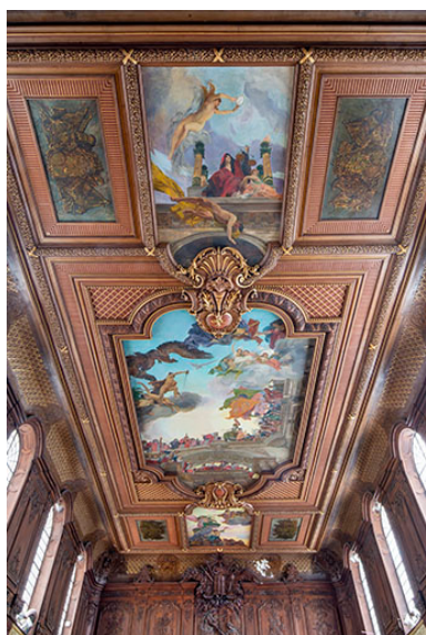
Vue d'ensemble du plafond.
