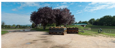
Berges aménagées. Phot. Pierre-Marie Barbe-Richaud IVR26_20112103939NUC4AQ
