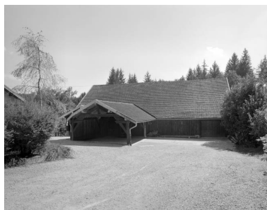
Façade nord de l'atelier de fabrication.
