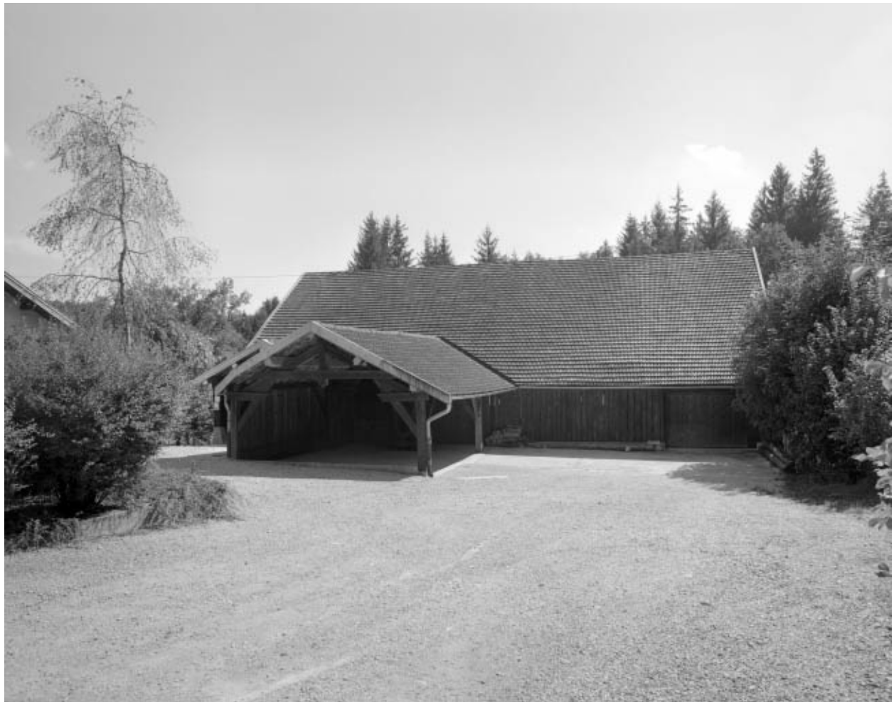
Façade nord de l'atelier de fabrication.
