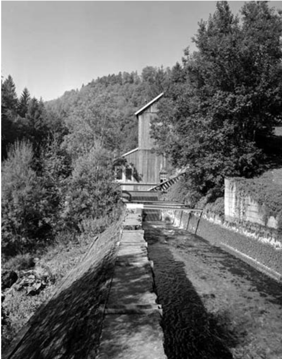
Canal d'amenée de la centrale hydroélectrique.
