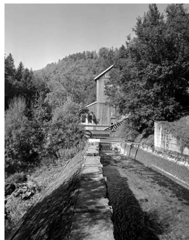
Canal d'amenée de la centrale hydroélectrique.
