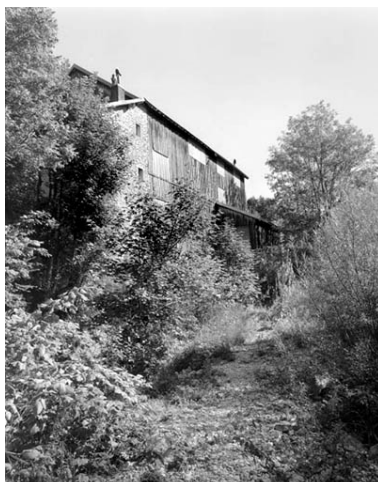
Façade sur l'Ain de l'atelier de fabrication.
