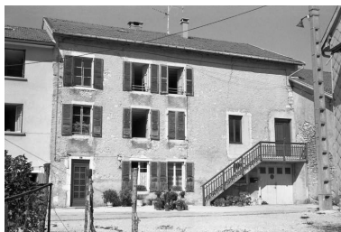
Ancienne fabrique de mètres. Phot. Laurent Poupard
