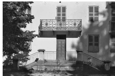
Façade postérieure du logement patrimonial : porte d'entrée et balcon. Phot. Laurent Poupard IVR43_19903900600Z
