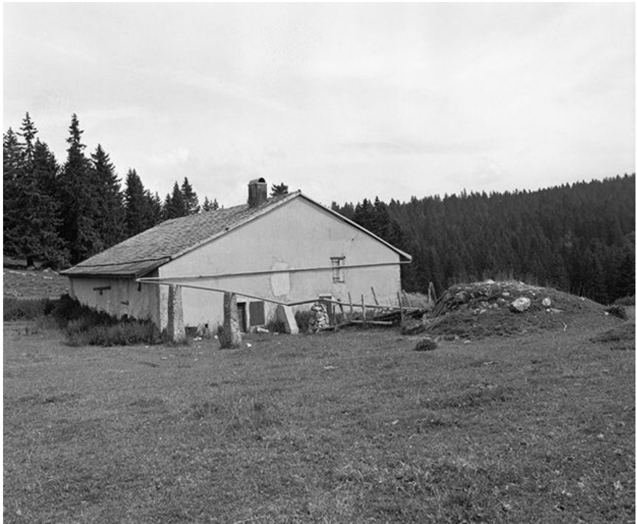
Façades postérieure et latérale gauche.
