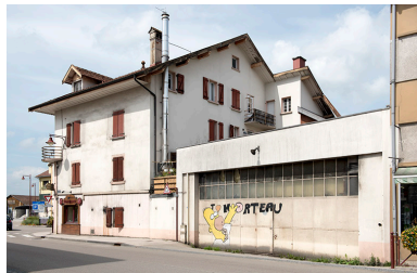
Façade latérale droite. Phot. Sonia Dourlot IVR43_20182500948NUC4A
