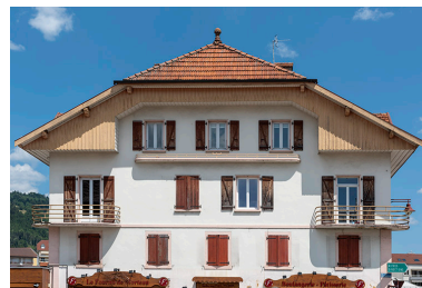
Façade antérieure : étages. Phot. Sonia Dourlot IVR43_20182501250NUC4A
