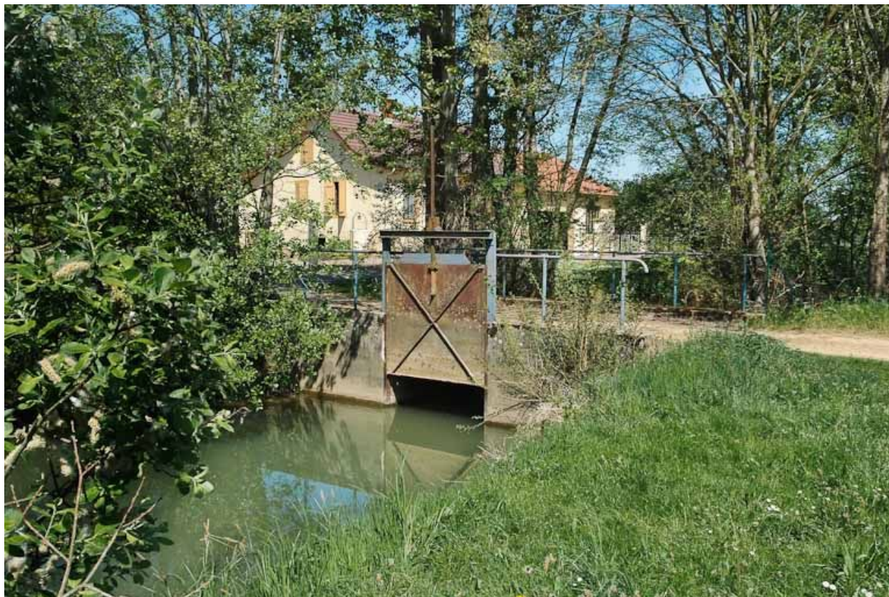
Vue d'ensemble : vanne.
