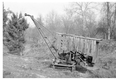
Grue sur voie étroite dans l'ancienne carrière. Phot. Laurent Poupard IVR43_19883900355Z
