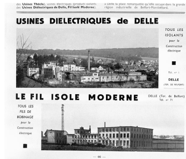
Usines Diélectriques de Delle - Le Fil Isolé Moderne. Phot. Jérôme Mongreville IVR43_20019000529X
