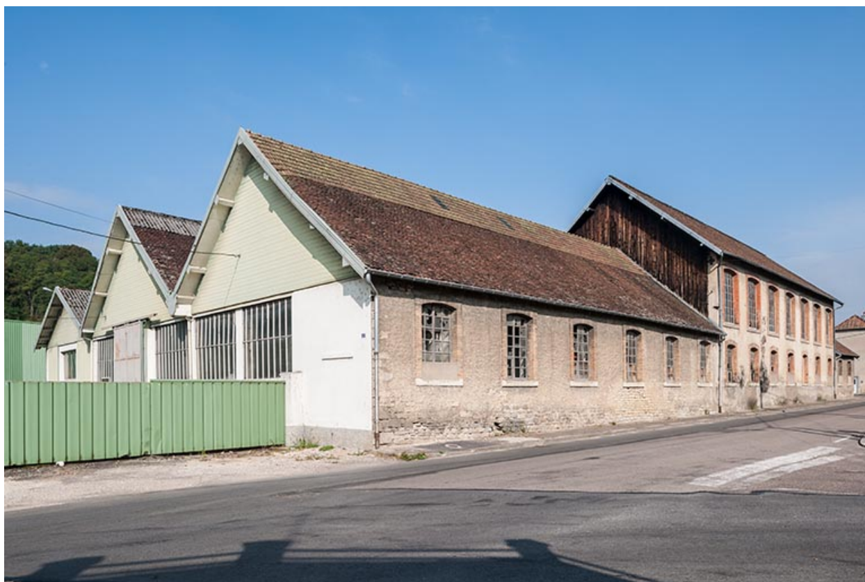
Atelier de fabrication depuis le sud-est.
