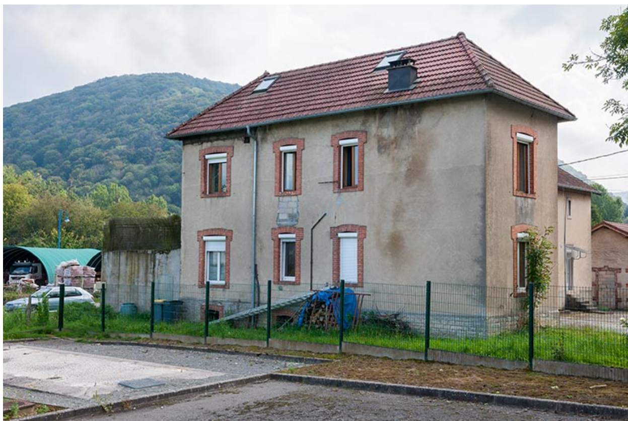
Logement ouvrier rue de Santoche. Façade postérieure.
