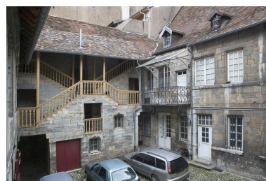
Vue d'ensemble de l'escalier à cage ouverte. Phot. Yves Sancey IVR43_20092501361NUC2A
