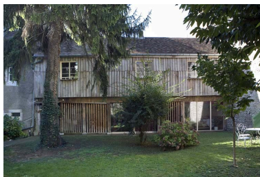
Vue d'ensemble du bûcher, de face. Phot. Yves Sancey IVR43_20092501368NUC2A
