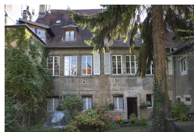
Vue d'ensemble de la façade postérieure du logis secondaire. Phot. Yves Sancey
