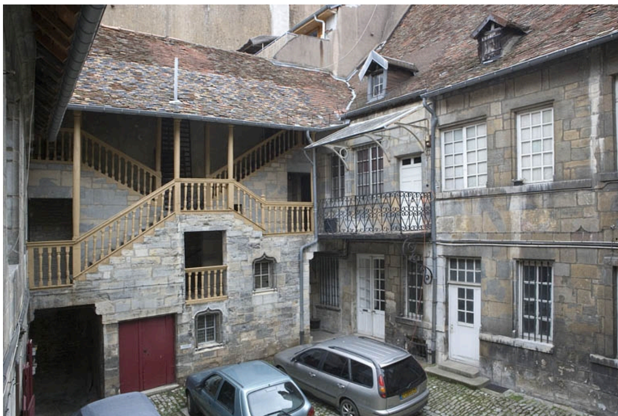
Vue d'ensemble de l'escalier à cage ouverte.
