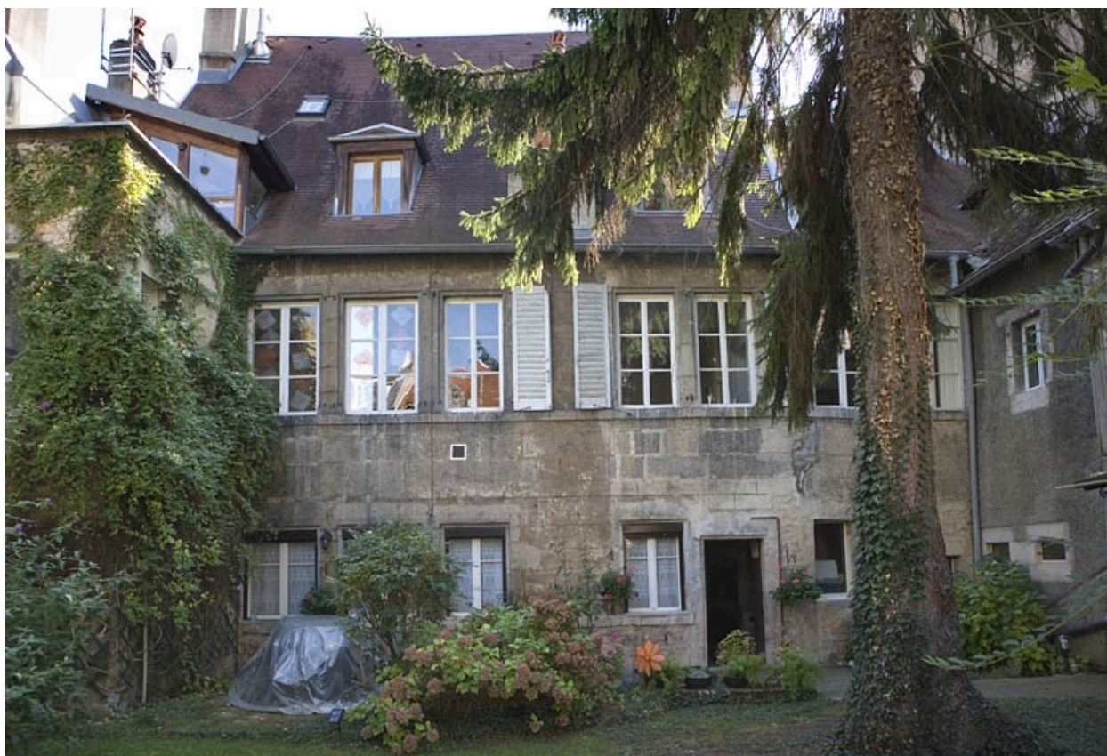
Vue d'ensemble de la façade postérieure du logis secondaire.
