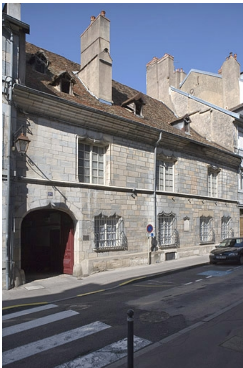
Vue d'ensemble de la façade sur rue, de trois quarts gauche.
