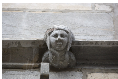
Façade sur rue : détail d'une tête de femme sur le bandeau d'appui, de face. Phot. Yves Sancey IVR43_20092501352NUC2A
