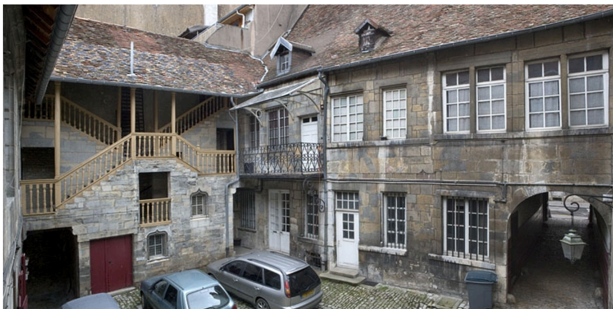
Vue d'ensemble de la façade postérieure du logis sur rue et de l'escalier à cage ouverte sur cour.
