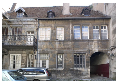
Vue d'ensemble de la façade postérieure du logis sur rue. Phot. Yves Sancey IVR43_20092501358NUC2A
