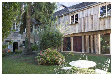
Vue d'ensemble depuis le fond du jardin. Phot. Yves Sancey IVR43_20092501367NUC2A
