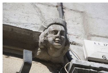
Façade sur rue : détail d'une tête d'homme à l'extrémité droite du bandeau d'appui. Phot. Yves Sancey IVR43_20092501354NUC2A
