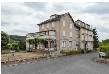
Élévation sur la rue Joseph Duriaux. Phot. Pierre-Marie Barbe-Richaud IVR26_20195800441NUC4A
