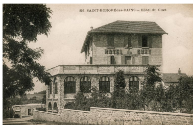
Vue ancienne. Autr. auteur inconnu IVR26_20195800233NUC4A
