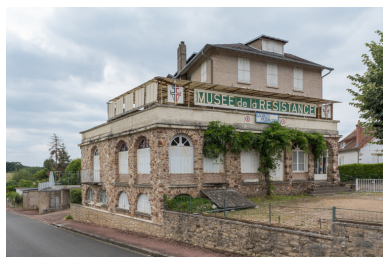
Vue de l'hôtel et du restaurant depuis l'est. Phot. Pierre-Marie Barbe-Richaud IVR26_20195800442NUC4A
