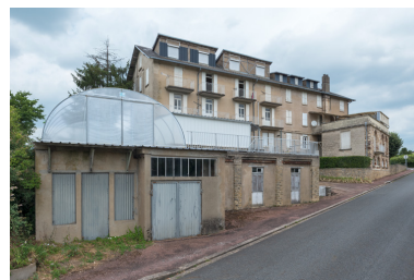
Élévation sur la rue de la Beaume Vignot. Phot. Pierre-Marie Barbe-Richaud IVR26_20195800443NUC4A
