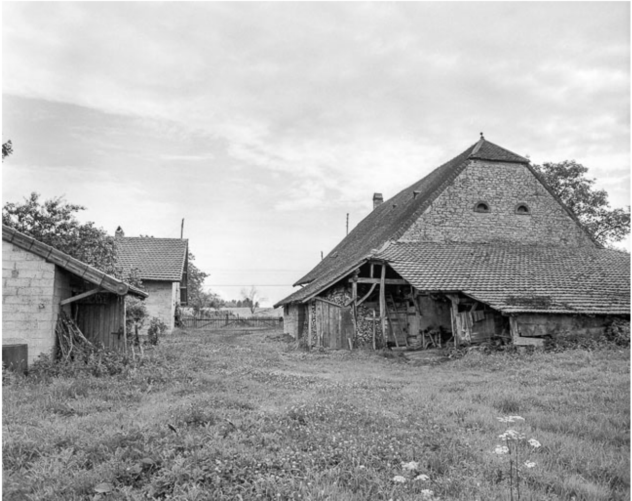
Façades postérieure et latérale gauche.
