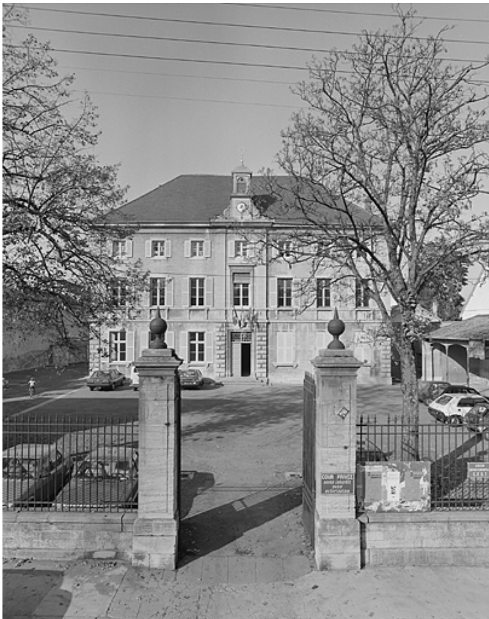
Ecole, 76 rue Saint-Désiré, vue d'ensemble.
