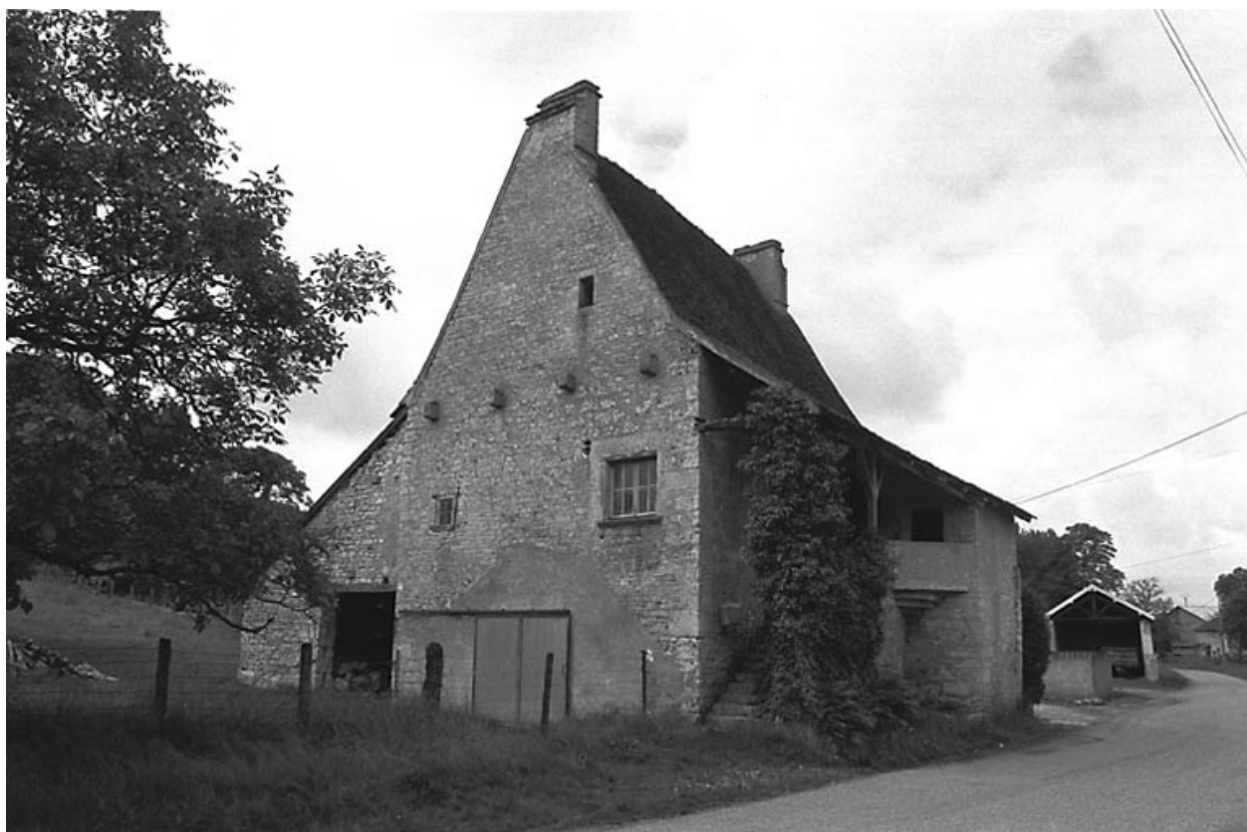
Maison située rue de l'Eglise : vue d'ensemble.
