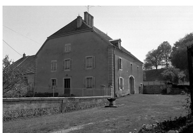
Ferme située rue de la Fontaine : vue d'ensemble. Phot. Bernard Lardière IVR43_19817000368Z
