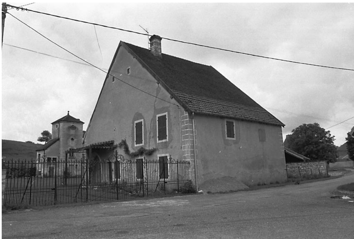
Ferme située rue Vierge de Chevigny : vue d'ensemble.
