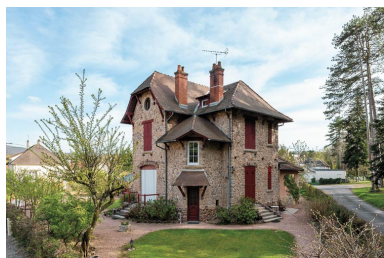
Vue d'ensemble depuis le nord-ouest. Phot. Pierre-Marie Barbe-Richaud IVR26_20195800014NUC4A
