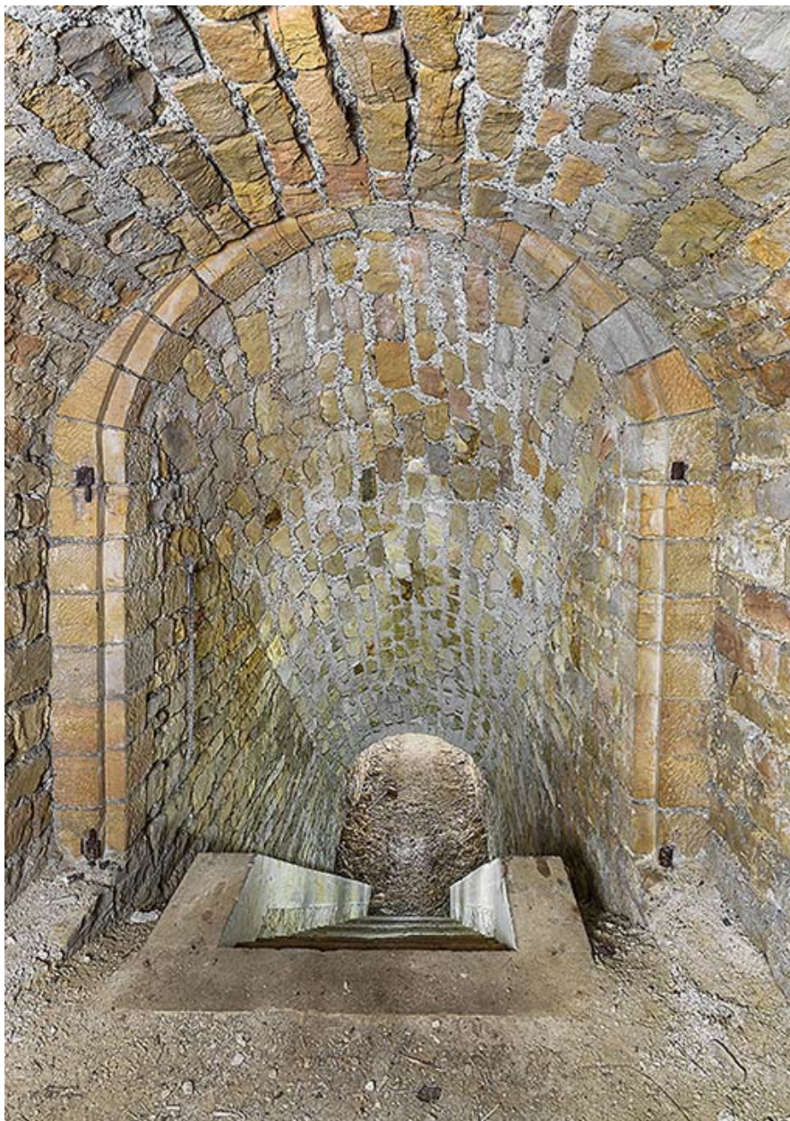
Rampe-escalier vers la double caponnière.
