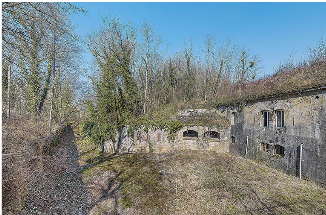
Front de gorge : fossé et coffres de l'escarpe.
