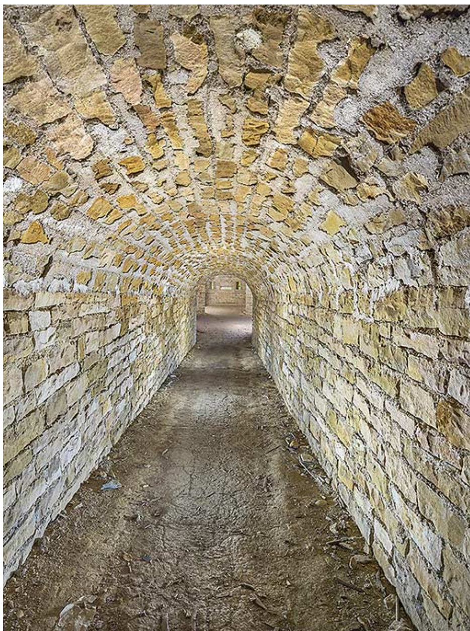
Couloir d'accès de la double caponnière.
