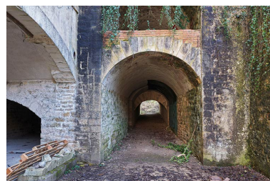
Une des deux gaines latérales donnant accès à la rue des Remparts depuis la cour centrale. Phot. Nicolas Douriaux IVR26_20262100365NUC4A
