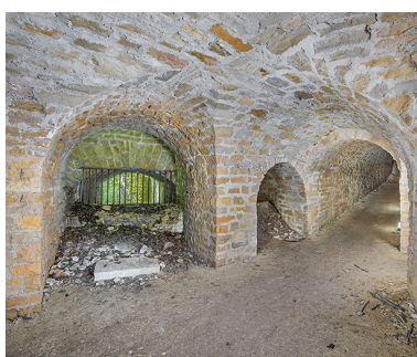
Créneau de tir en direction du fossé. Phot. Thierry Kuntz IVR26_20252100142NUC4A
