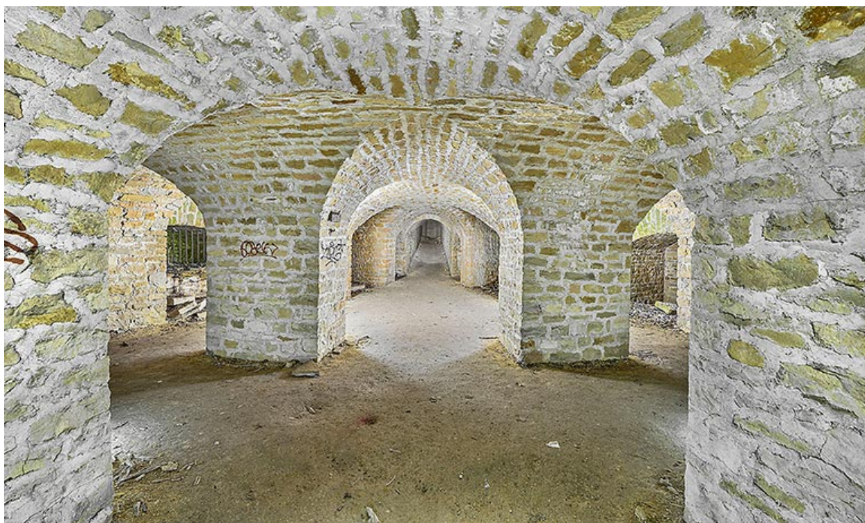
Vue générale de la double caponnière.
