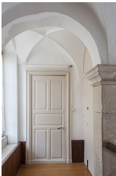
Palier du 1er étage. Phot. Jérôme Mongreville IVR43_20127000711NUC4A
