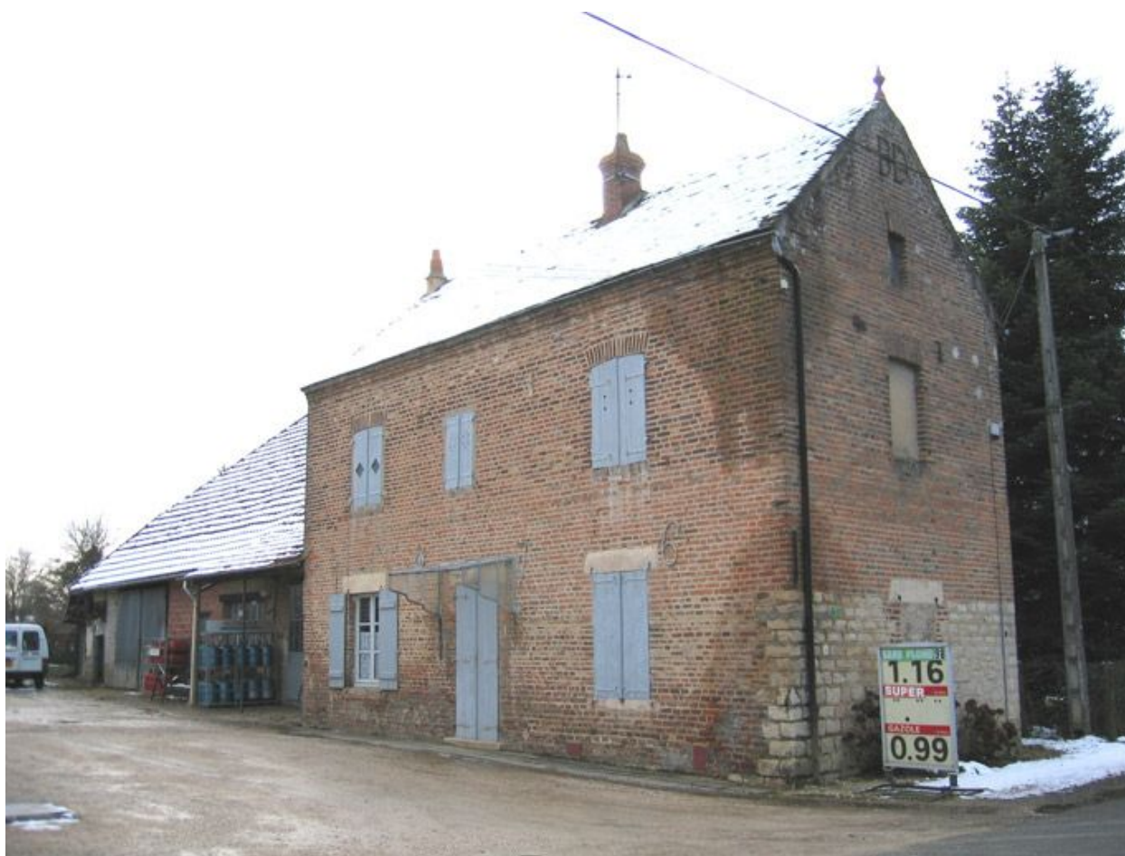
Vue d'ensemble de la façade.
