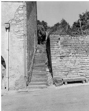
Escalier donnant accès au jardin. Phot. Bernard Lardière IVR43_19777000292X
