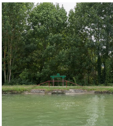
Vanne et déversoir vus du canal. Phot. Pierre-Marie Barbe-Richaud IVR26_20128900565NUC2AQ
