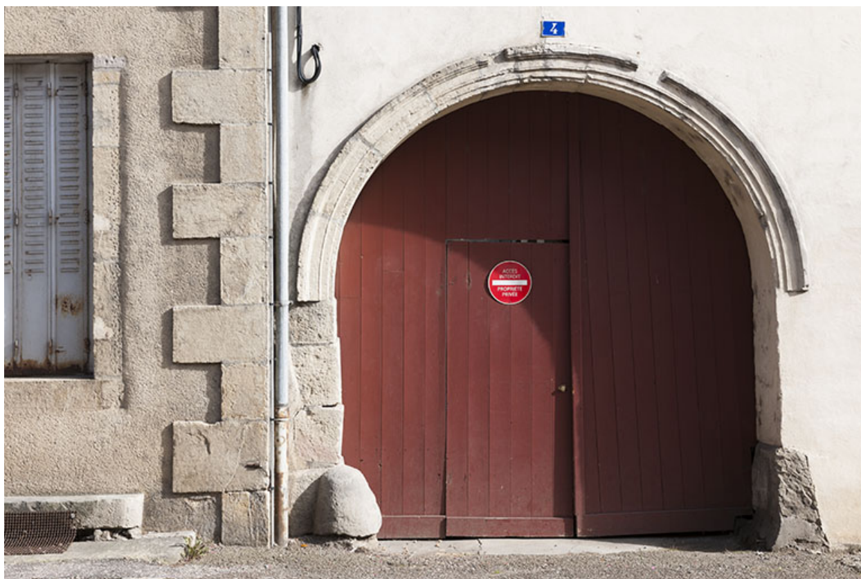
Porte charretière, Grande-Rue.
