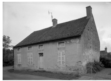
Vue d'ensemble du logis d'une ferme (cad. 1937, sect. A2, parc. 444). Phot. Michel Rosso IVR26_19862100610V
