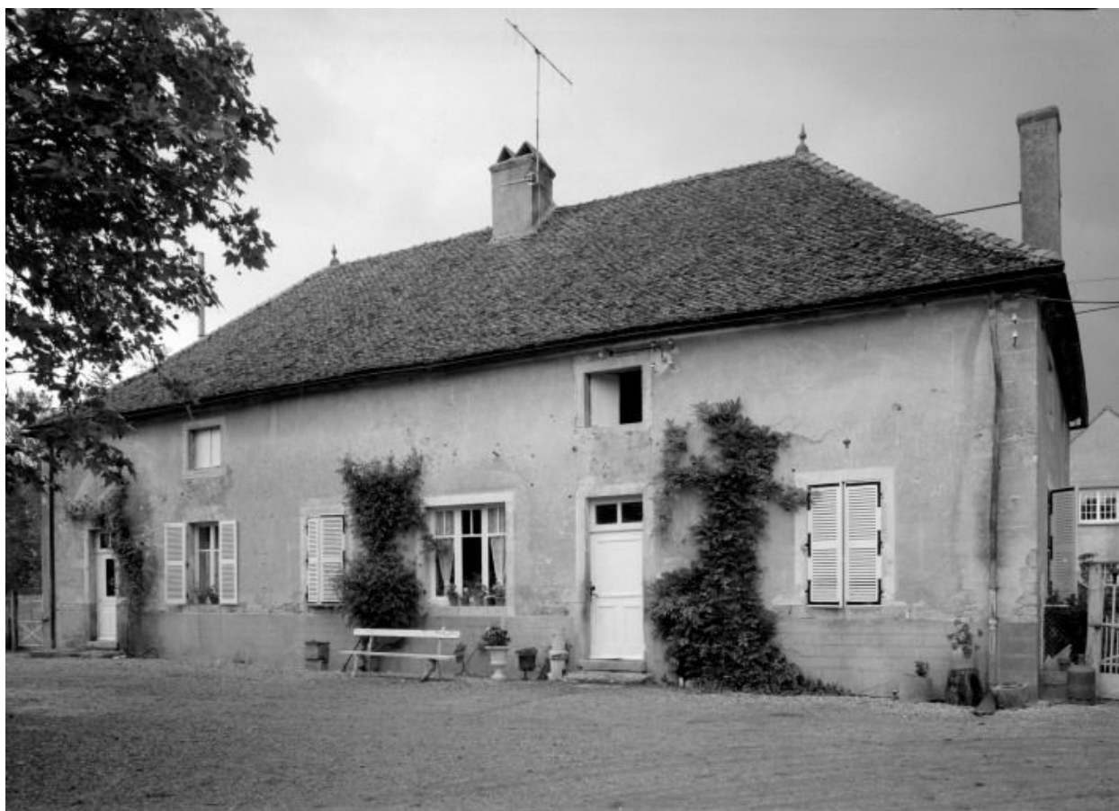
Vue d'ensemble du logis d'une ferme (cad. 1937, sect. A2, parc. 11).
