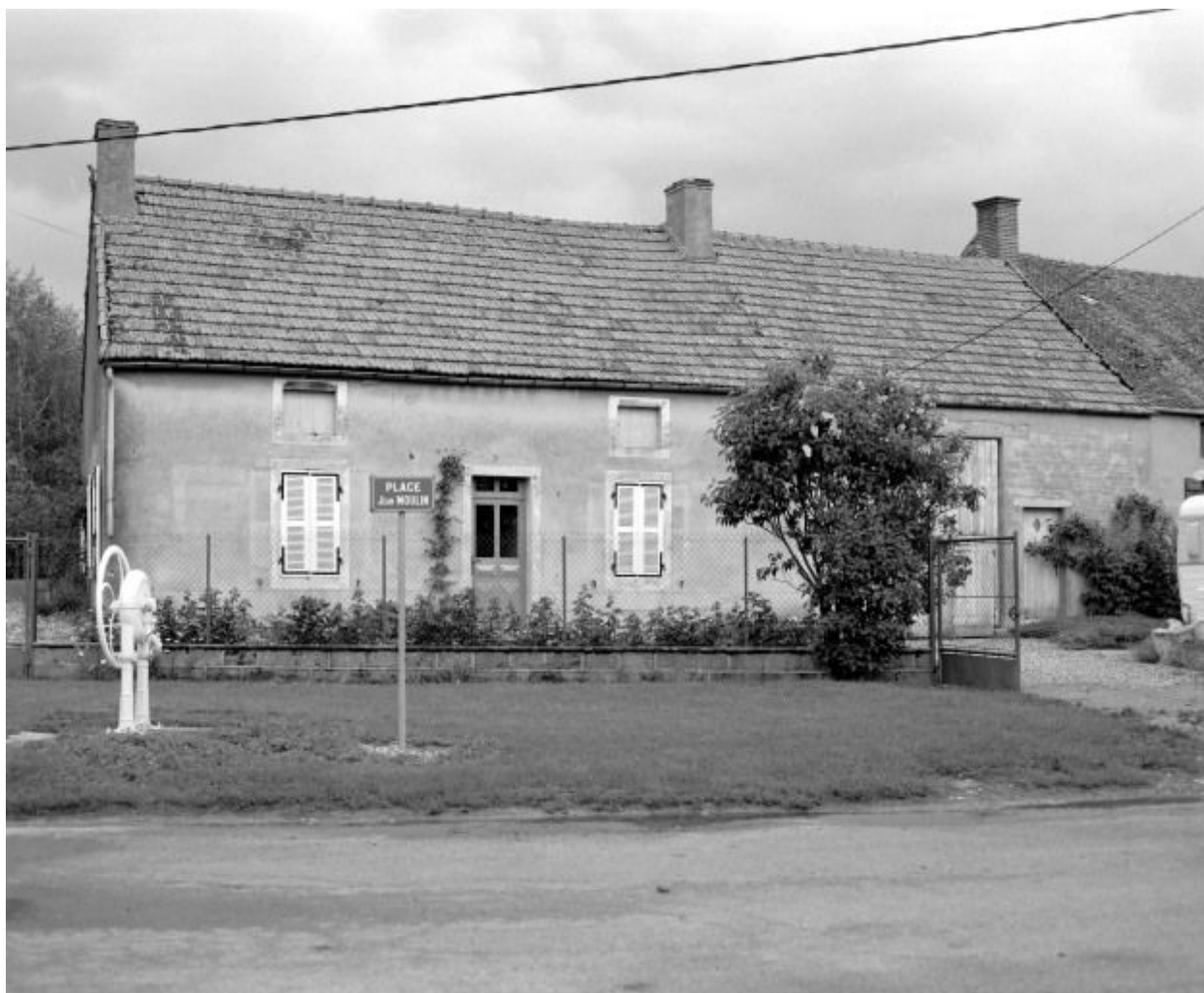
Vue d'ensemble du logis d'une ferme (cad. 1937, sect. A2, parc. 450).
