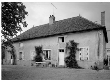
Vue d'ensemble du logis d'une ferme (cad. 1937, sect. A2, parc. 11). Phot. Michel Rosso IVR26_19862100618V
