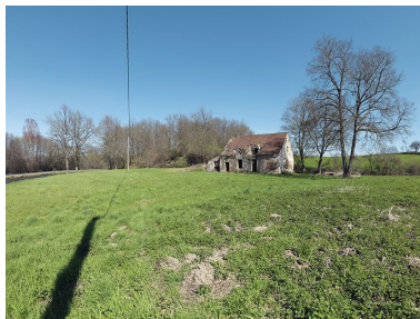
La maison éclusière. Phot. Thierry Kuntz IVR26_20137100113NUC4A
