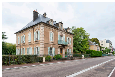
Rue de Grammont avec la Villa des Platanes. Phot. Jérôme Mongreville IVR43_20207000658NUC4A
