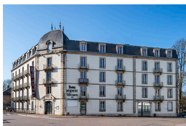
Hôtel des Sources. Phot. Jérôme Mongreville IVR43_20227000057NUC4A
