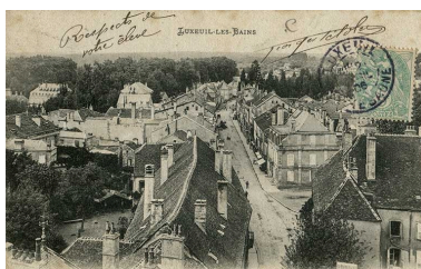
Rue Carnot, vue en direction du nord. Autr. auteur inconnu IVR43_20217000093NUC4A
