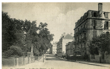
Rue des Thermes, vue en direction de l'est. Autr. auteur inconnu IVR43_20217000096NUC4A
