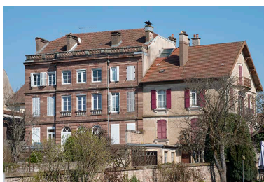
Maison Ganeval puis hôtel de La Terrasse (à gauche) et Villa Élisabeth (à droite). Phot. Jérôme Mongreville IVR43_20227000126NUC4A
