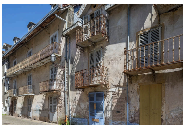
Balcons de la rue de la Fosse Pageot (actuelle allée des Romains). Phot. Jérôme Mongreville IVR43_20207000558NUC4A
